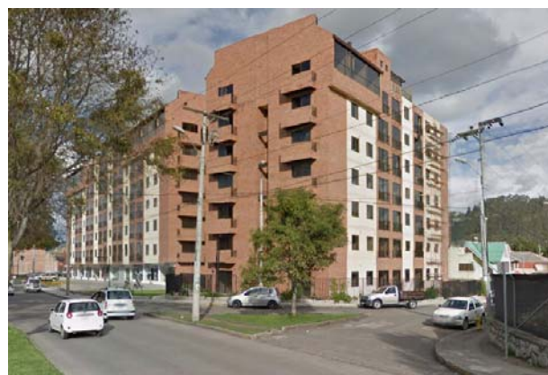
Foto 2.1. Vista hacia los multifamiliares
