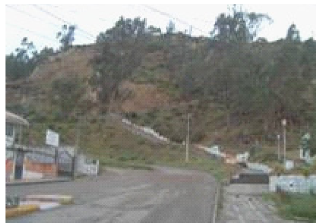
Fotografía. Corte de la vía y escalinata. Obtenida por: Silvia C. Gómez Carrión.
