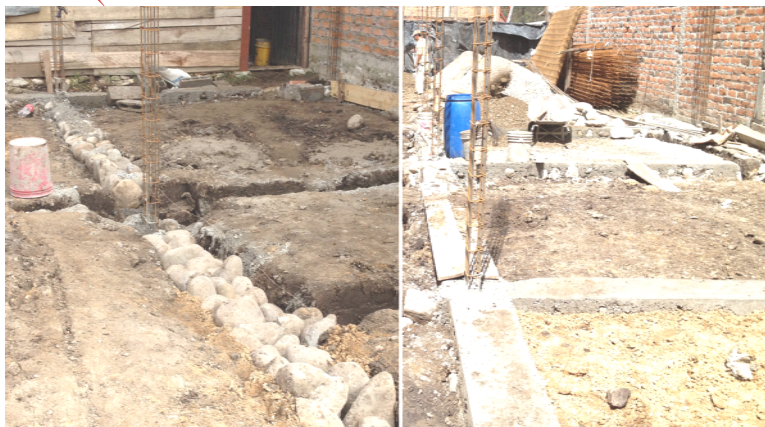
Figura 2. Construcción de cemento corrido. Fuente: el autor. 2012.
