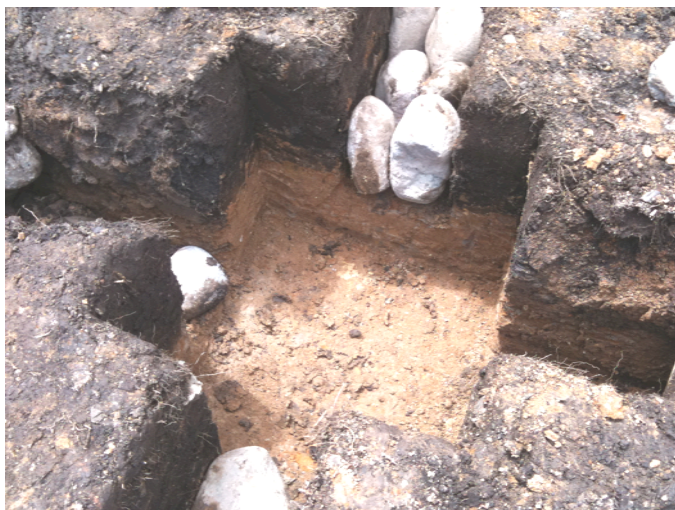
Figura 1. Estructura en porticos de hormigón armado cimentado sobre zapatas. Excavación de zapatas. Fuente: el autor. 2012.
