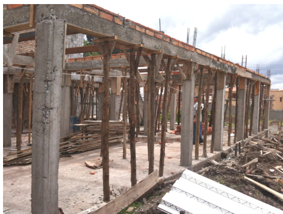
Figura 4. Estructura aporticada sin paredes de relleno, sobre losa de cimentación. Fuente: el autor. 2012.
