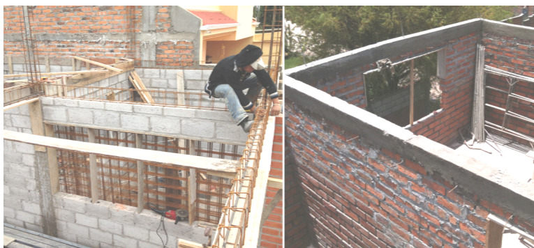
Figura 3. Estructura aporticada en hormigón armado: paredes de relleno en bloque de hormigón y en ladrillo panelón. Fuente: el autor. 2012.
