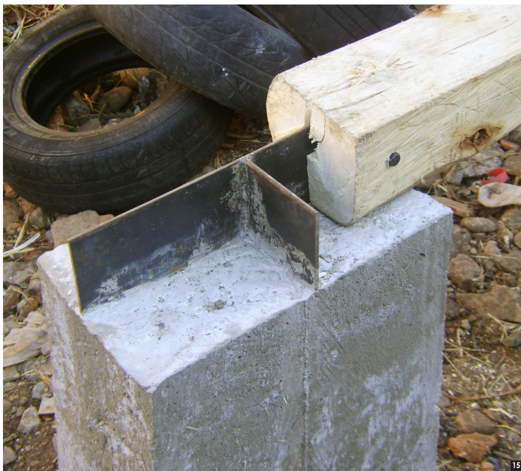
151. Viga de madera de 16 x 16cm. sujeta a placa de anclaje "T" con pernos de 7" y fundida en dado de hormigón central de 20 x 40cm
