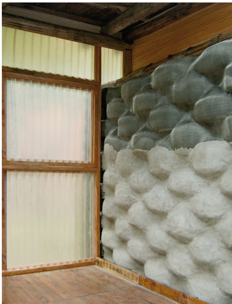
Paneles de plastiluz con estructura de madera. Muro de llantas enlucido con mortero sobre malla
