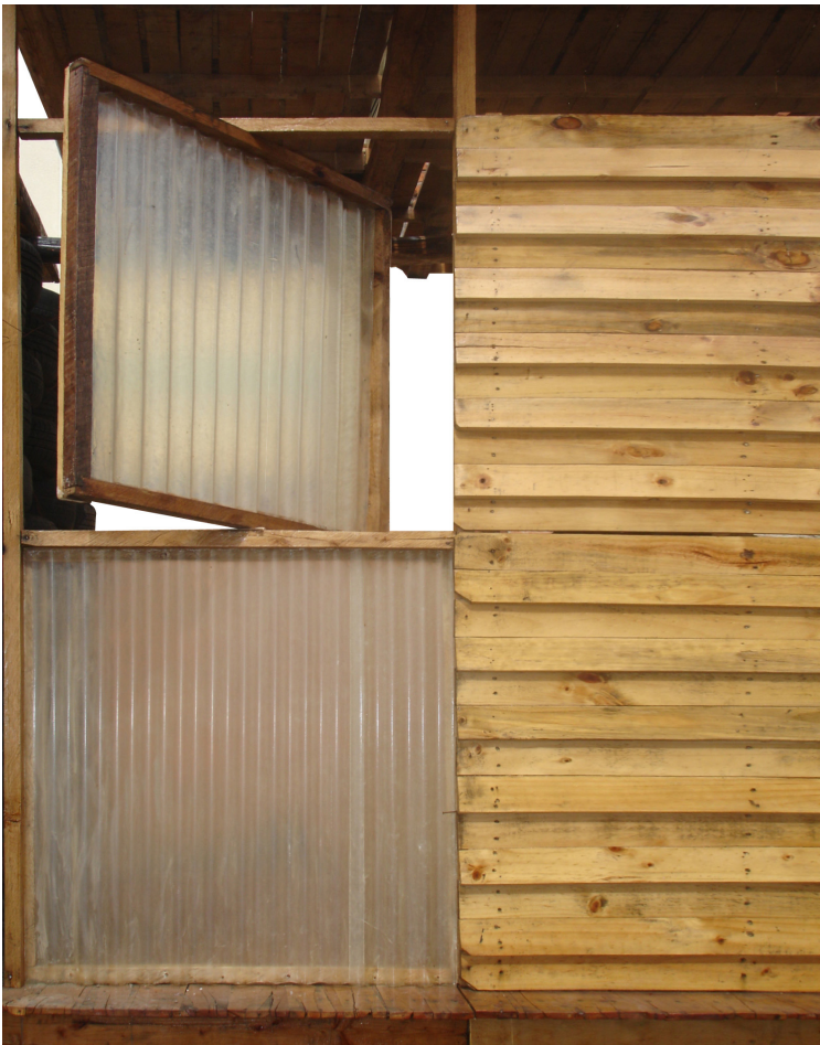
Ventana con sistema pivotante
