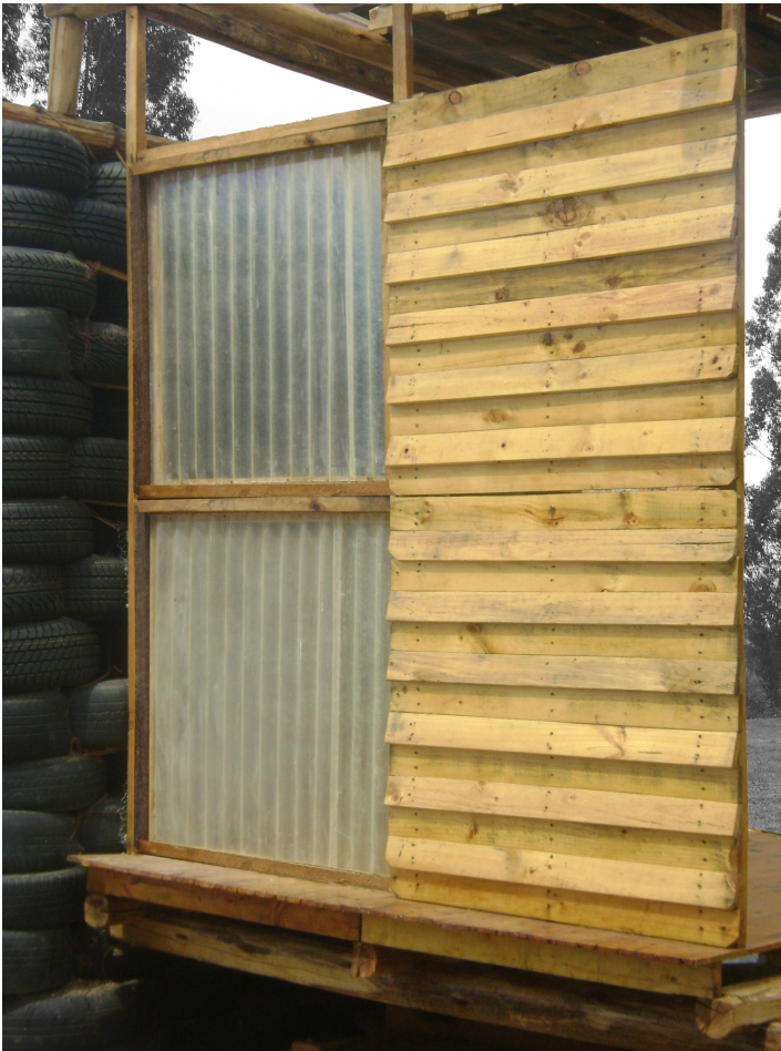
Cerramiento frontal: Palets de madera y ventanas fija y pivotante de platiluz con estructura de madera
