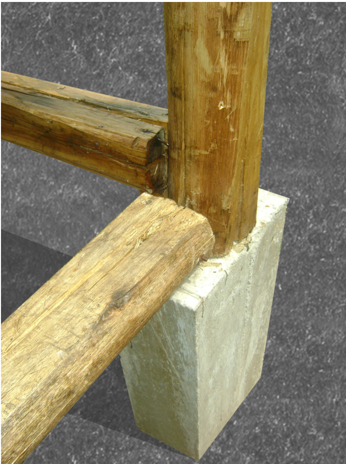
Sistema estructural de la vivienda: Vigas y columnas de madera sobre dado de hormigón.
