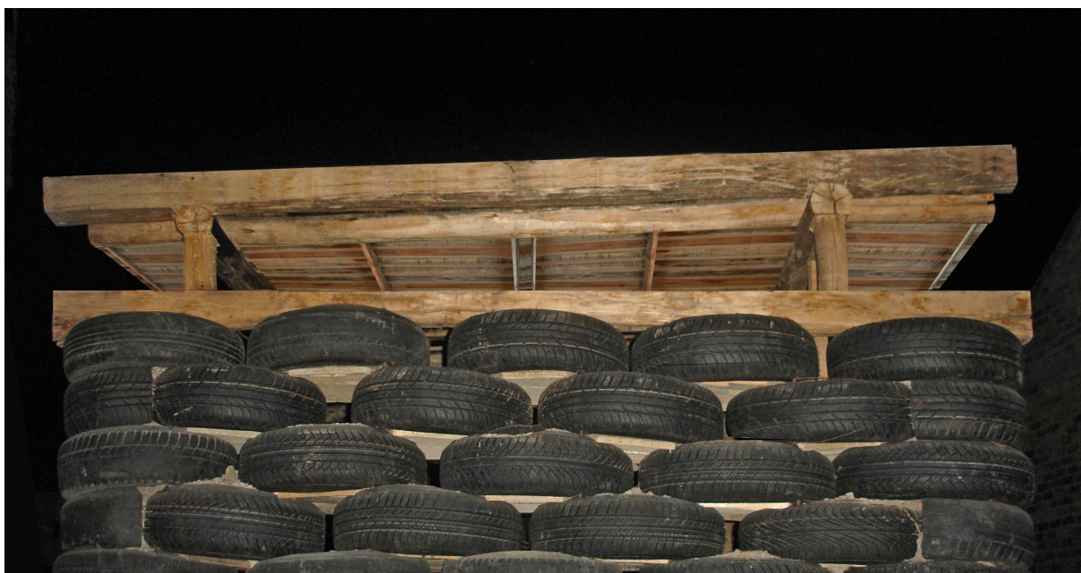
Remate de muro de llantas con viga de madera 14x14cm.
