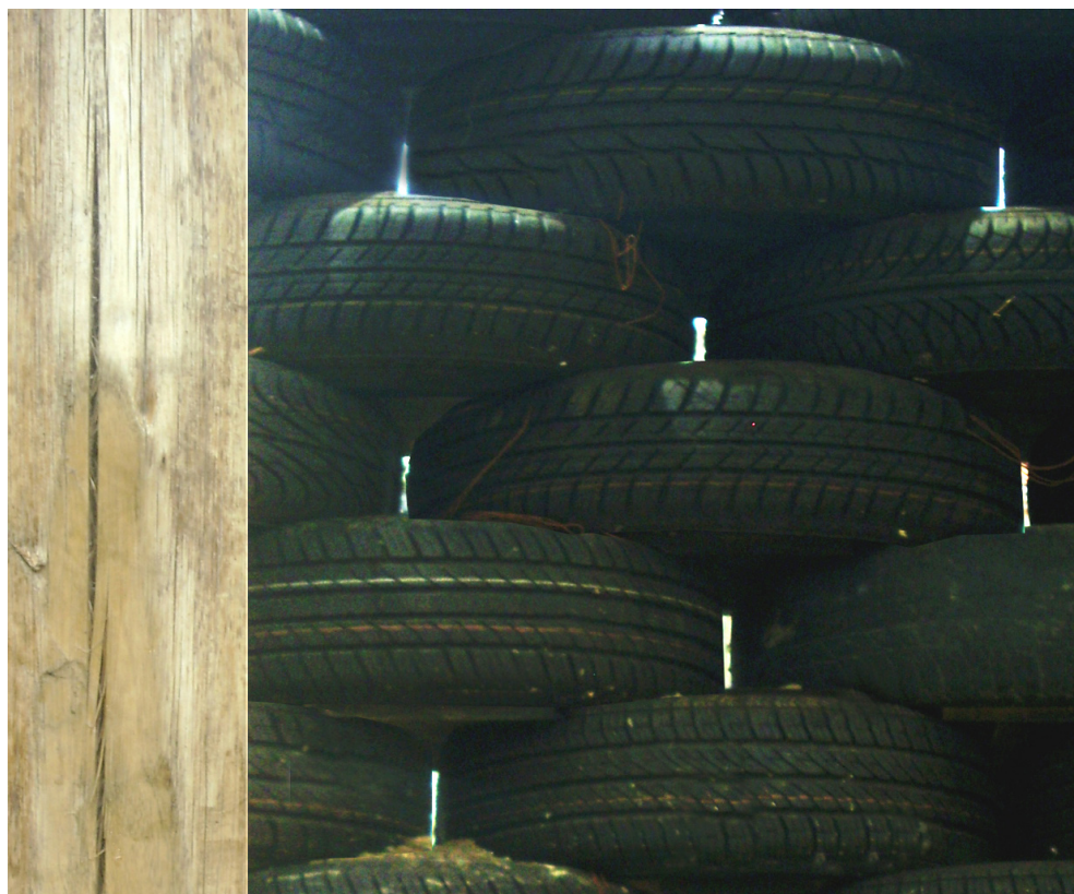
Estructura de madera y muro de neumáticos desechados
