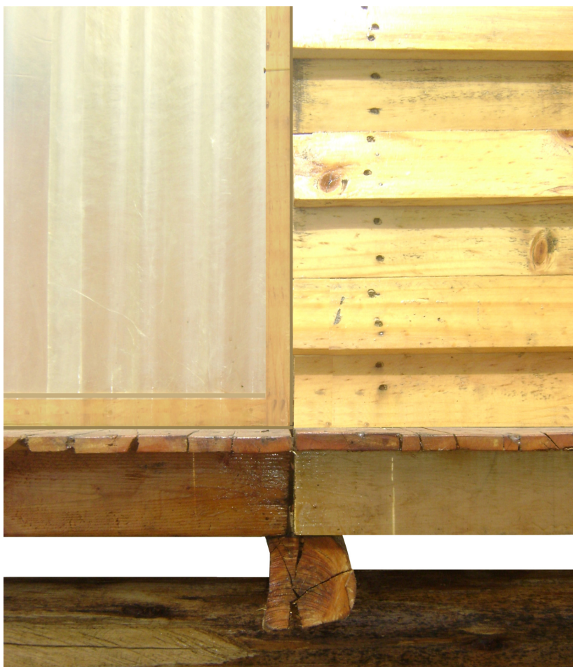
Detalle constructivo de fachada. Vigas de madera con viguilla transversal como sustento de los elementos de piso y cerramiento frontal
