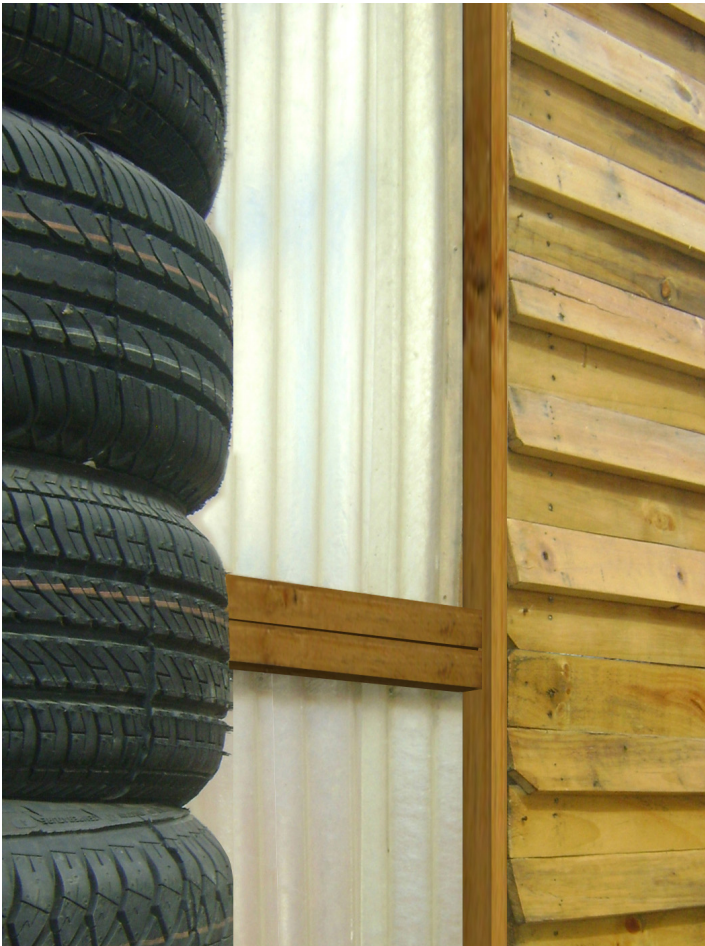
Cerramiento frontal: neumáticos desechados, ventana fija y pivotante de plastiluz con estructura de madera, palets de madera de pino
