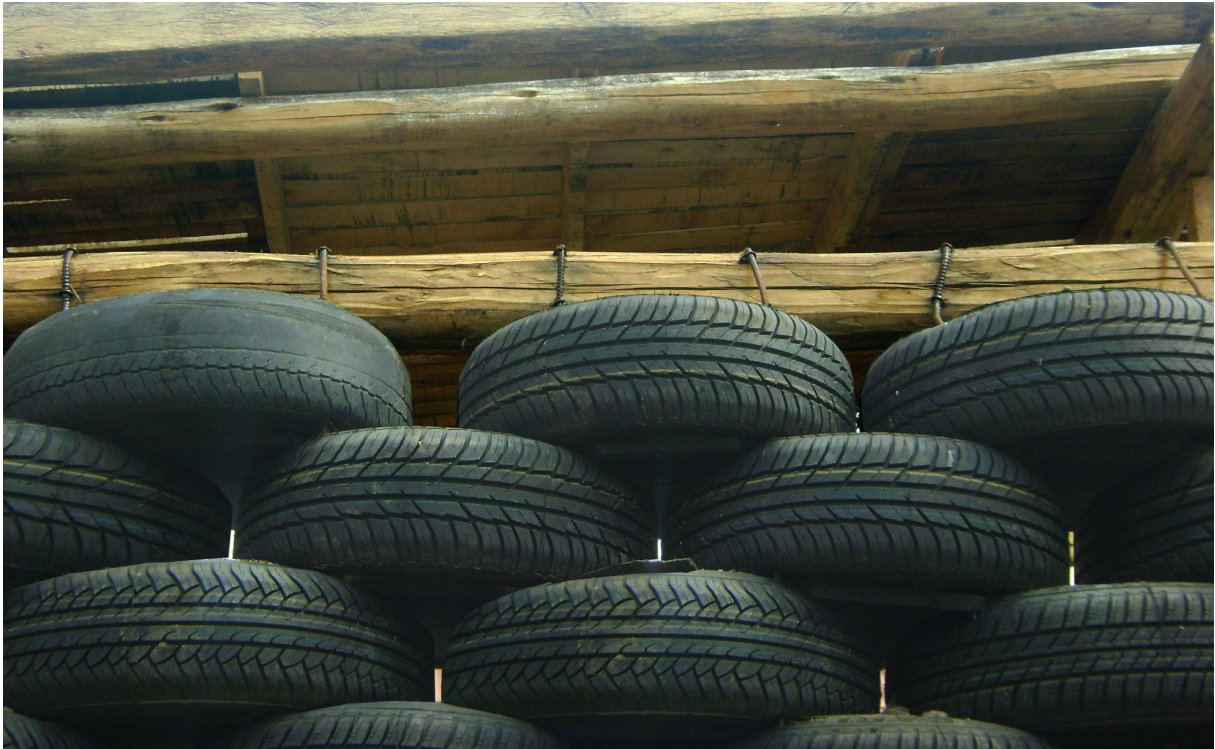
Remate de muro con viga de madera a la cual se sujetan varillas de hierro que atraviesan los neumáticos desde sus cimientos
