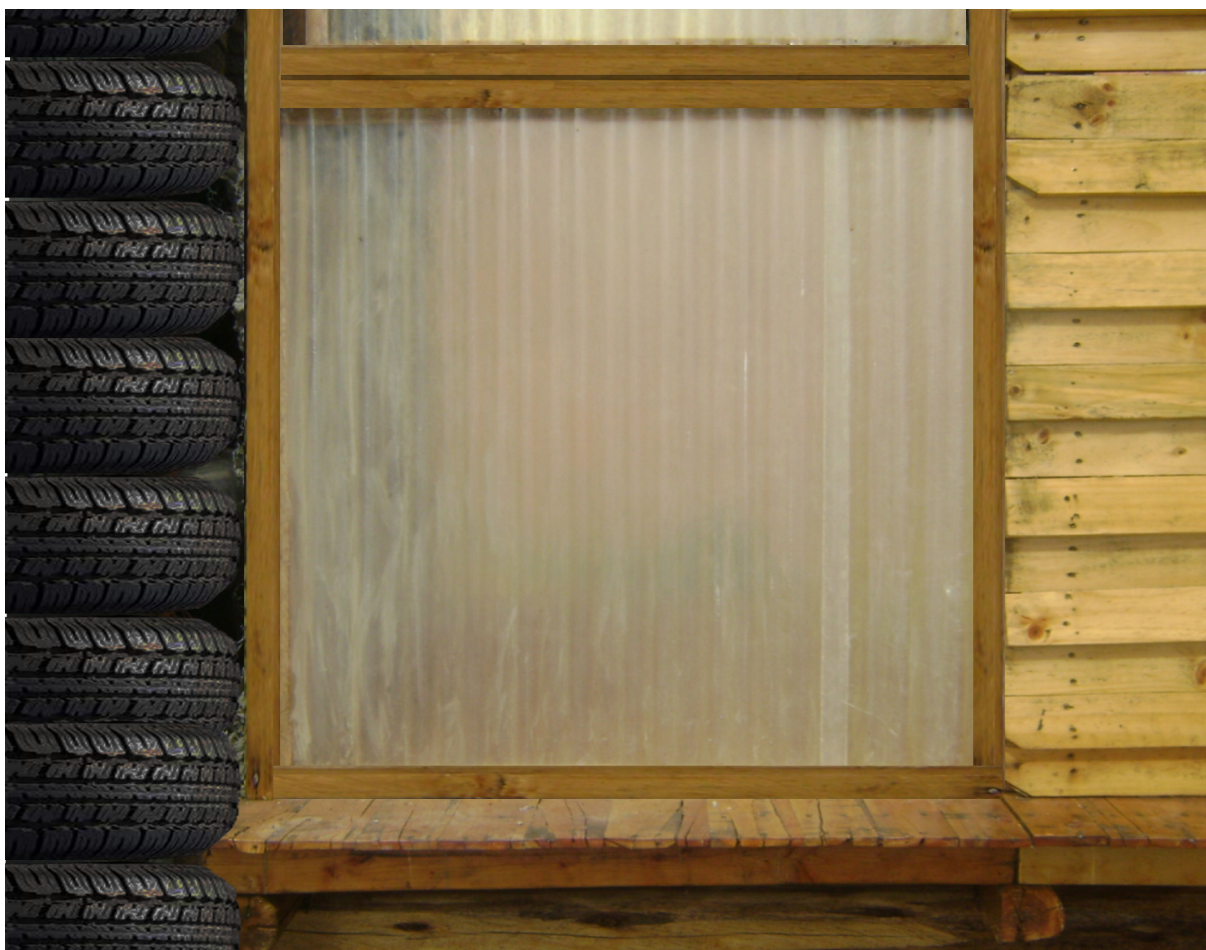
Alzado frontal. Texturas generadas por materiales reutilizados : neumáticos, palets de madera y plástiluz
