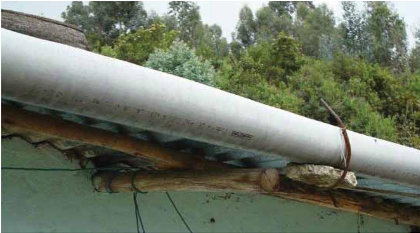
La utilización de tubos de PVC como canales en los aleros de cubierta es una solución recurrente en varias edificaciones.
