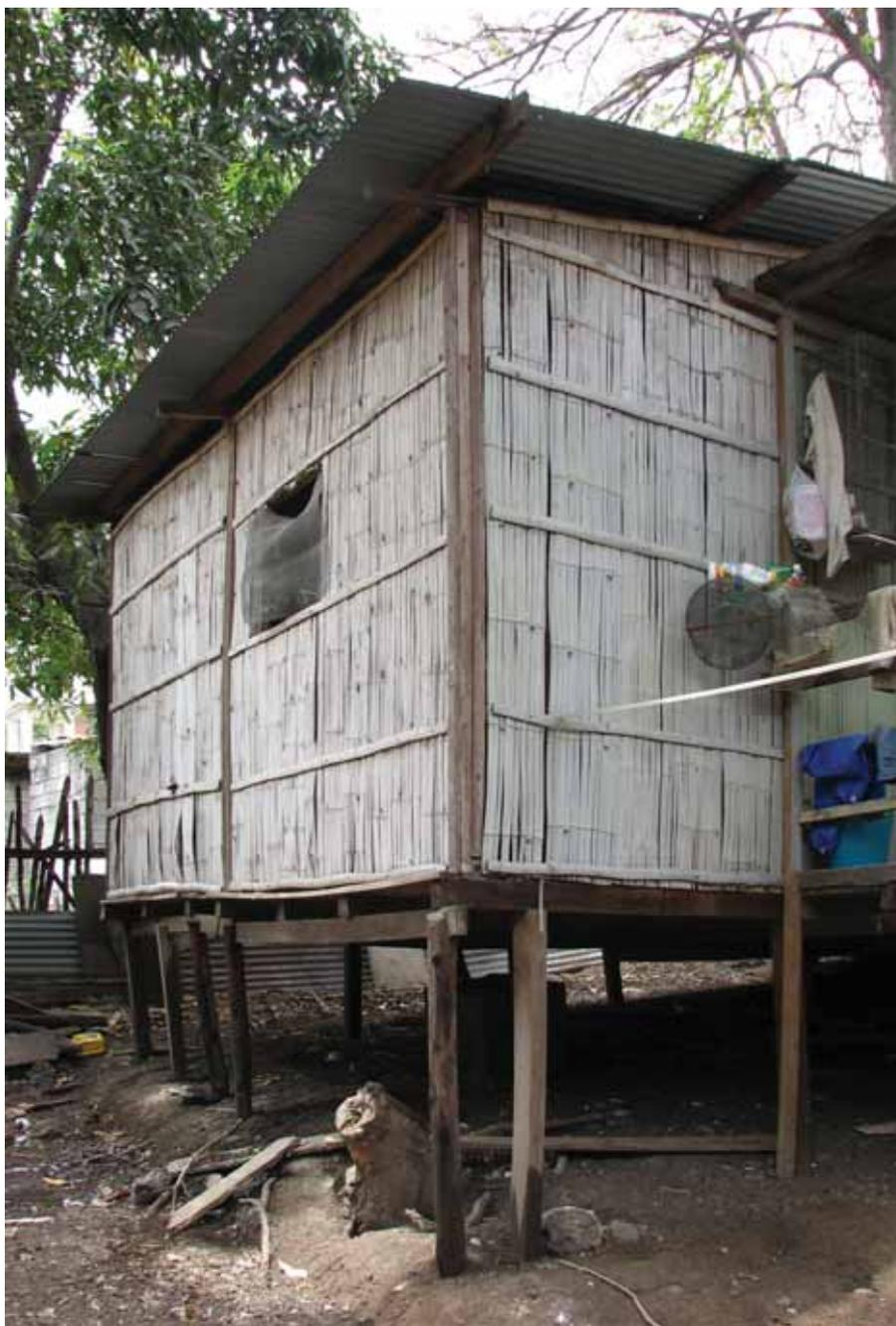
Imagen de una solución repetida en la ciudad Guayaquil, donde se utiliza una estructura de madera con tabiques de caña. La casa se asienta sobre pilotes en contacto directo con la tierra por lo que sufre un rápido deterioro.
