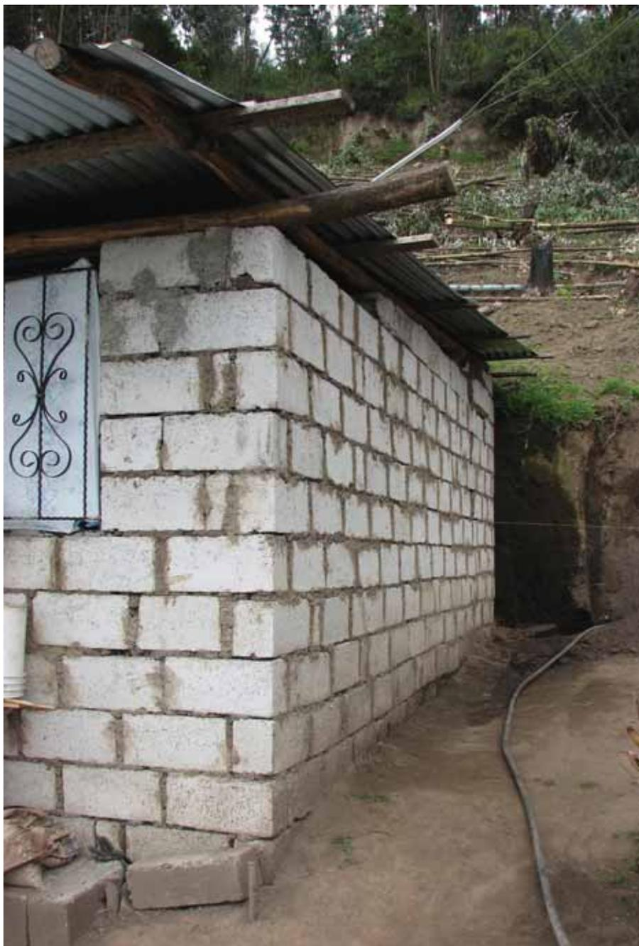
Imagen común de la solución constructiva en la ciudad de Quito. Nótese que no existe cimentación, pues se coloca el bloque directamente en contacto con el suelo. Las juntas se hacen con tierra y se apega la pared posterior contra el terreno.
