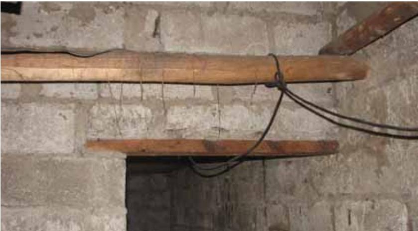
En esta imagen se rescata la utilización de la madera para la conformación de los dinteles de puertas y ventanas.
