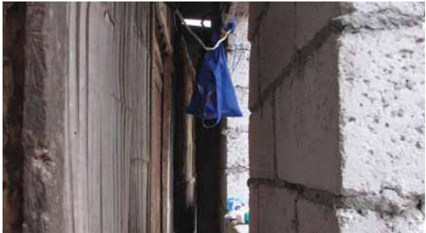
El interior de las viviendas se recubre con plástico para evitar la entrada de viento y agua por las aberturas de las tablas.
