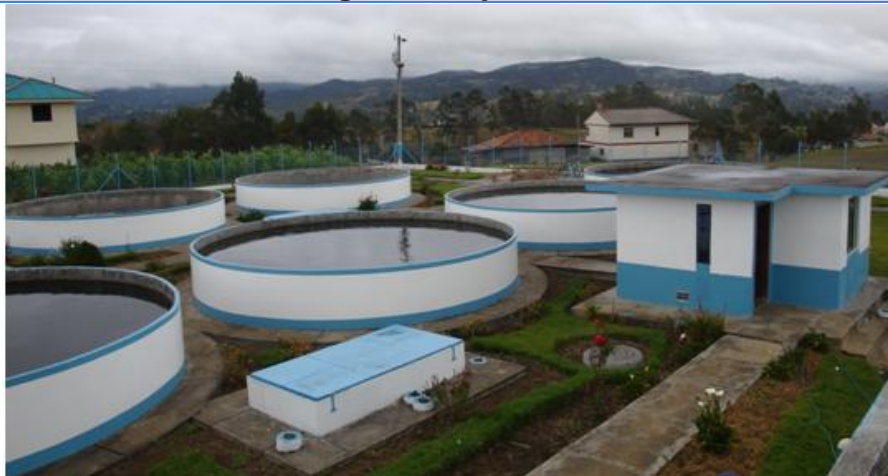
Fotografía 2.3.2.2 Filtros lentos del Sistema de Agua Regional Cojitambo.
