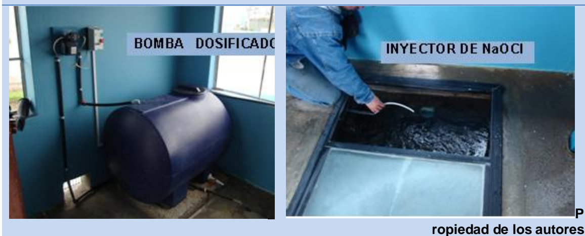
Fotografía 2.3.2.3-b Equipo dosificador de NaOCl.
