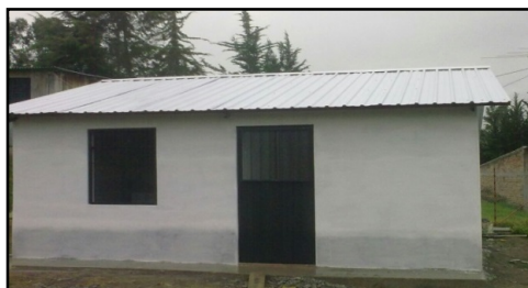
[Imagen 12]. Puerta metálica 1,00x2,10m.
