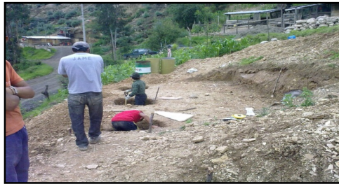
[Imagen 7]. Excavación de cimientos.
