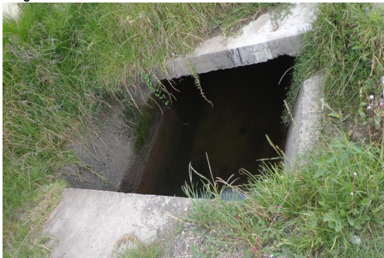
Imagen 3.17 CANAL DE RIEGO MACHÁNGARA EMBaulado
