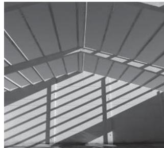
28 Vigas prefabricadas de hormigón.
