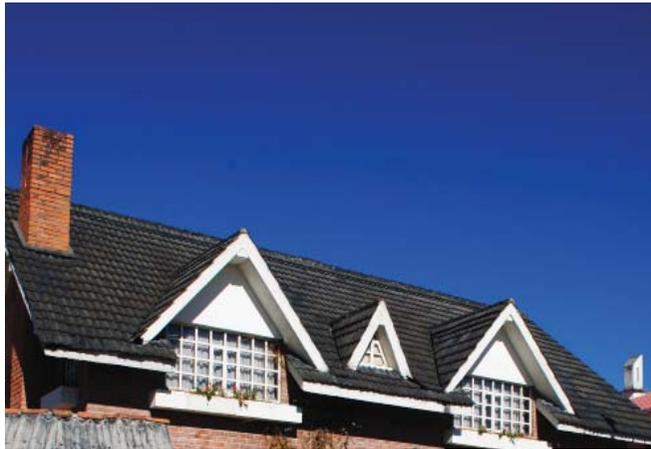
18 Vivienda con cubierta inclinada de teja de cemento
