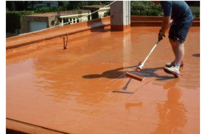
10. Membranas líquidas en cubierta plana no transitable.
