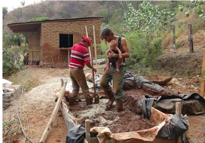
04 Preparación de la mezcla en el proceso de fabricación artesanal
