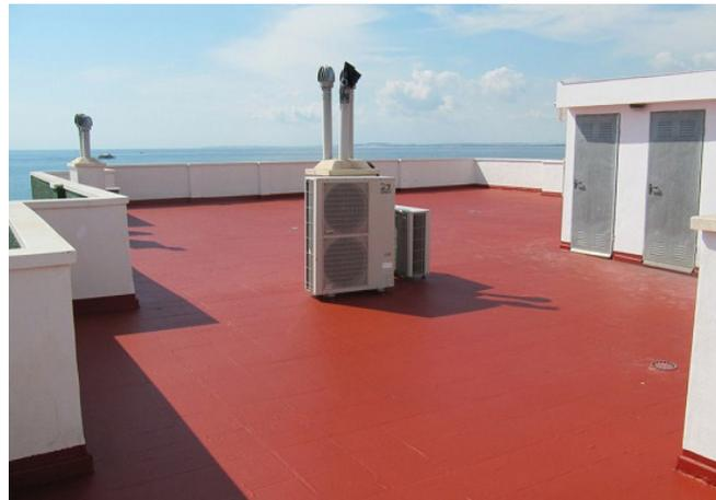
06. Recubrimiento de caucho clorado en terraza caminable.
