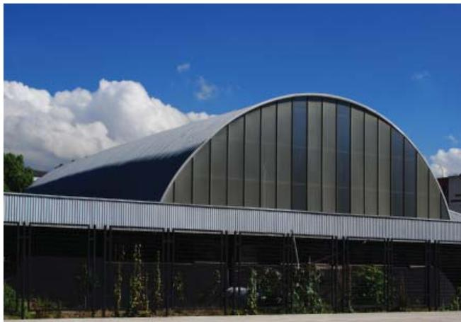
23 Piscina con cubierta abovedada metálica
