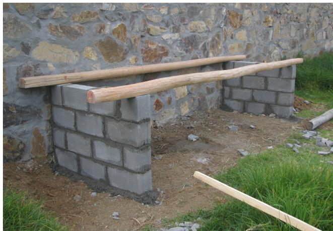
148 Construcción de paredes de bloque y colocación de vigas de madera
