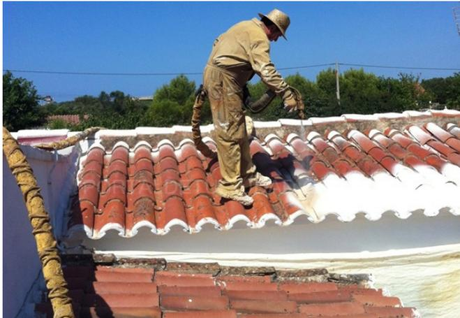
08. Aplicación de membranas líquidas de poliuretano en cubiertas inclinadas.
