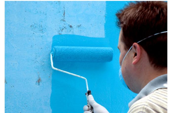
07. Recubrimiento de caucho clorado en pared.
