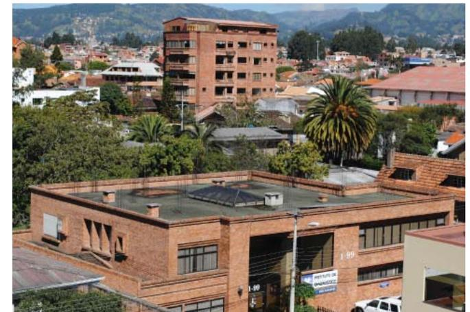
24 Edificio con cubierta plana no transitable de hormigón armado.
