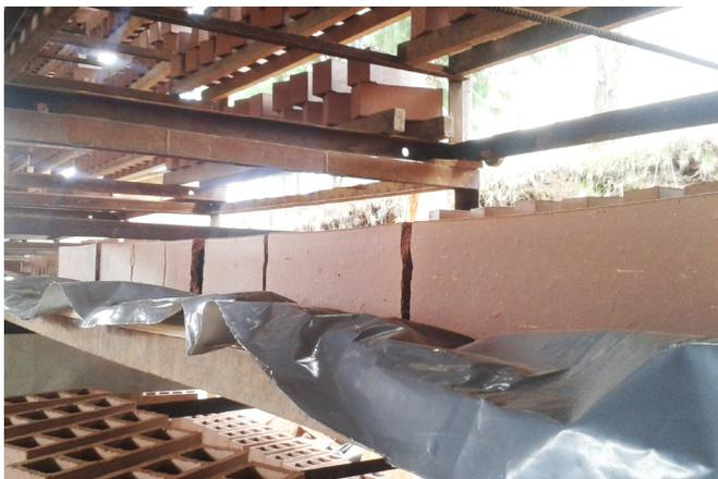
57 Rotura de pieza de arcilla de 2.50cm de longitud.
