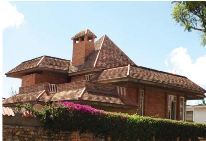
21 Vivienda con cubierta inclinada de ladrillo
