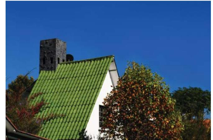
22 Vivienda de cubierta inclinada de fibrocemento con acabado de pintura.
