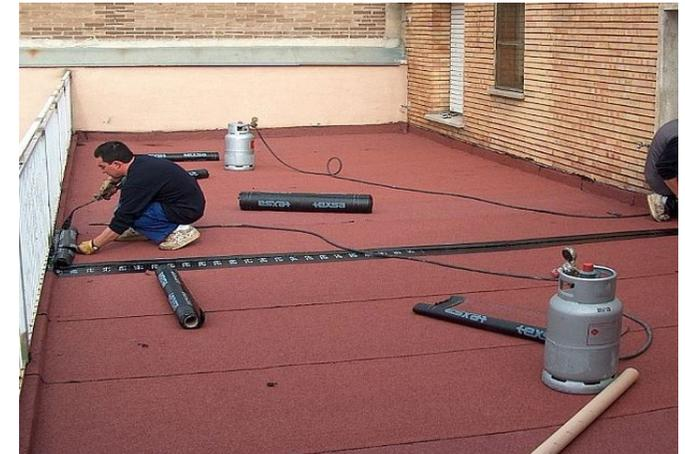
13. Colocación de láminas bituminosas en cubierta transitable.
