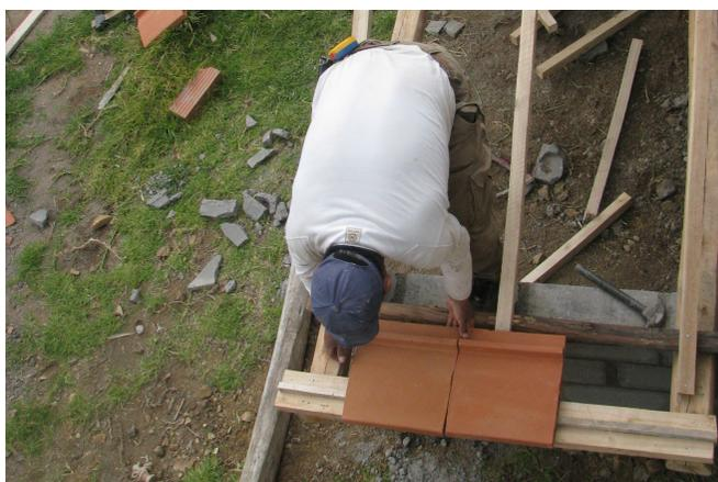
155 Colocación de la primera fila de la segunda ala de la cubierta
