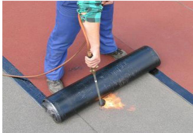
12. Colocación de láminas bituminosas con soplete.
