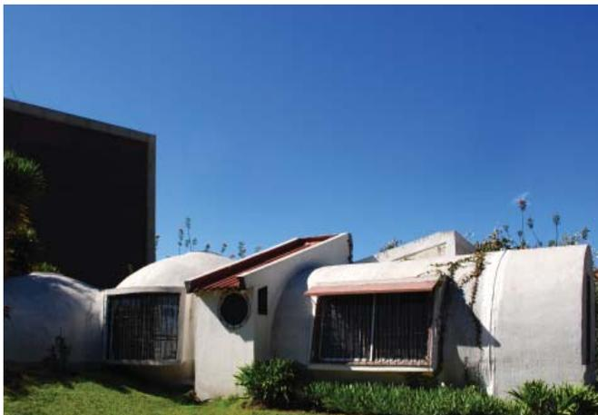
25 Edificación con cubierta abovedada de hormigón
