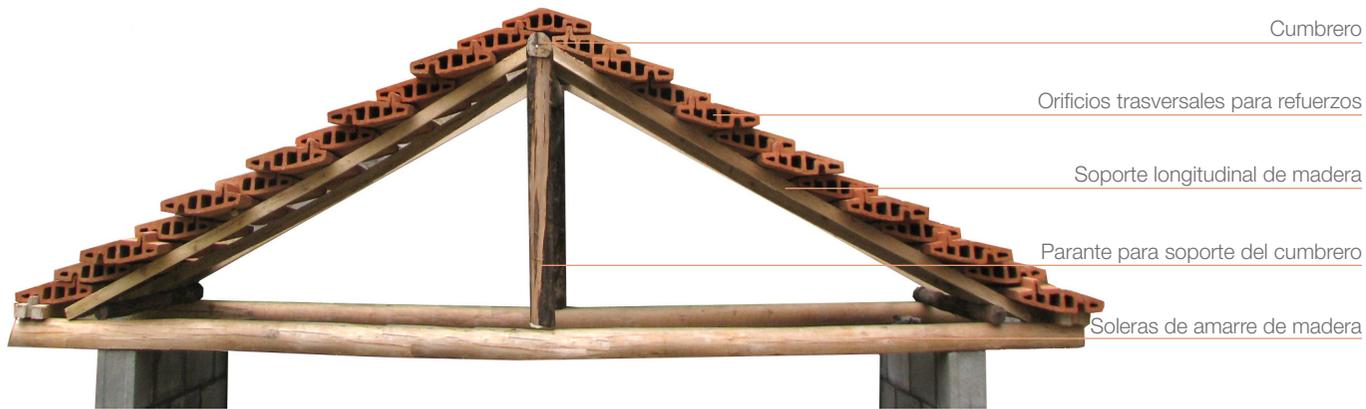
96 Prototipo construido de cubierta con piezas cerámicas
