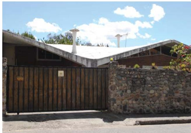
26 Vivienda con cubierta hiperbólica de hormigón armado
