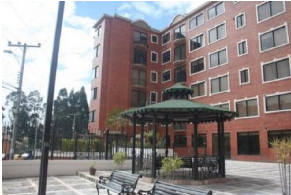
14 Ubicaciones y viviendas preferidas por los Expats (Edificio La Glorieta)
