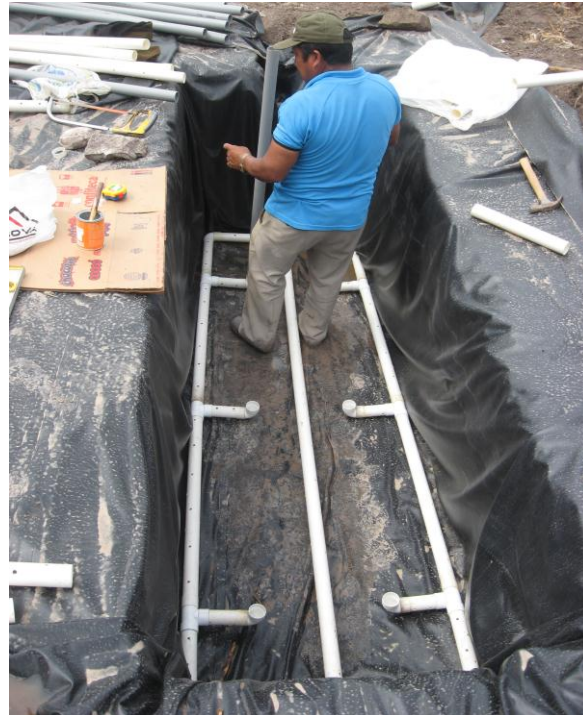
Fotografía 31. Colocación de tuberías de ventilación.
