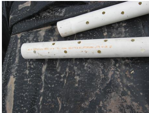
Fotografía 29. Tuberías de recolección con orificios.
