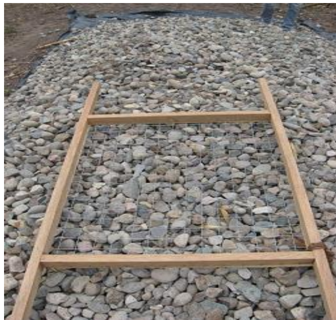
Fotografía 37. Tamiz 2x2 cm para primera capa de material filtrante.
