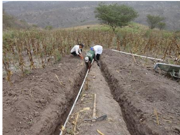
Fotografía 20. Instalación de tuberías de salida del sistema.
