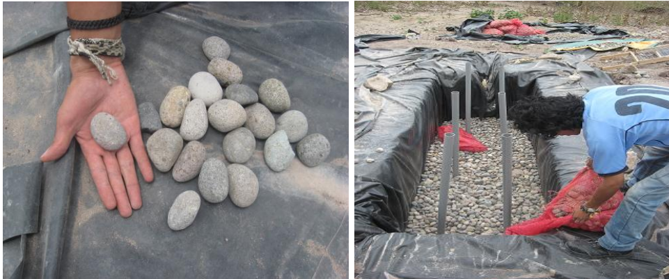
Fotografía 46. Izquierda: Material para segunda capa. Derecha: Colocación de segunda capa filtrante.
