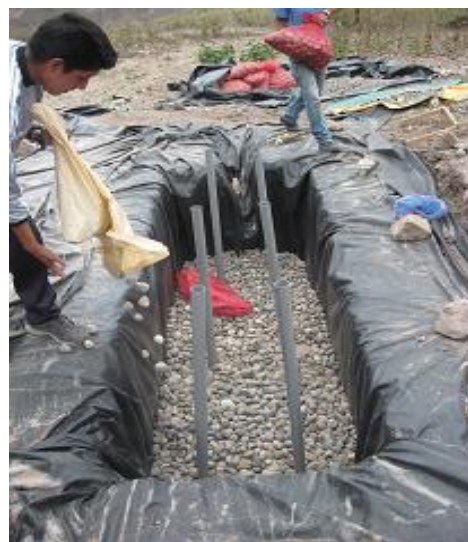
Fotografía 45. Izquierda: Material para primera capa. Derecha: Colocación de primera capa de material filtrante.
