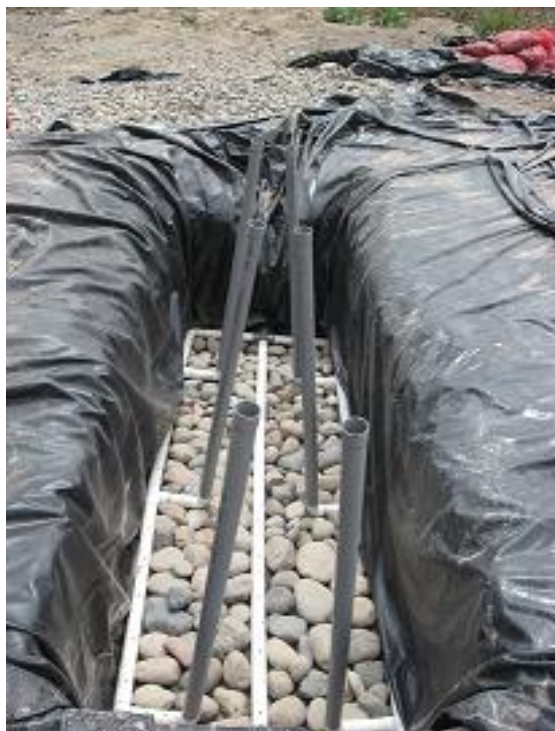
Fotografía 44. Colocación de una base de material para protección de tuberías.
