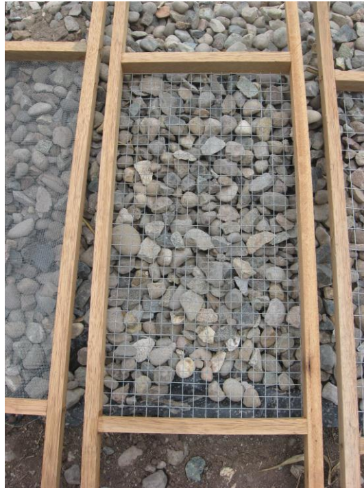
Fotografía 38. Tamiz 1x1 cm para segunda capa para material filtrante.
