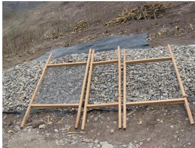
Fotografía 36. Tamices para clasificación de Material
