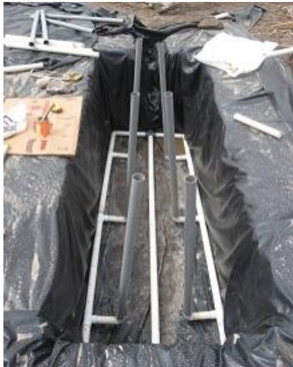
Fotografía 32. Vista de Tubería de Aireación y Recolección.
