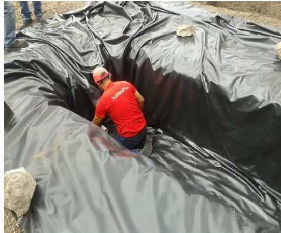
Fotografía 26. Perforación de geomembrana en tubería de salida de agua.
