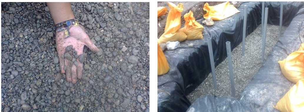
Fotografía 48. Izquierda: material para cuarta capa filtrante. Derecha: Colocación de cuarta capa.
