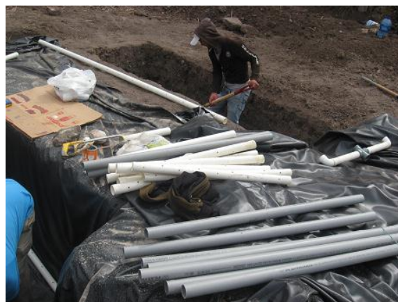
Fotografía 27. Materiales para la instalación de tuberías de drenaje y de aireación.
