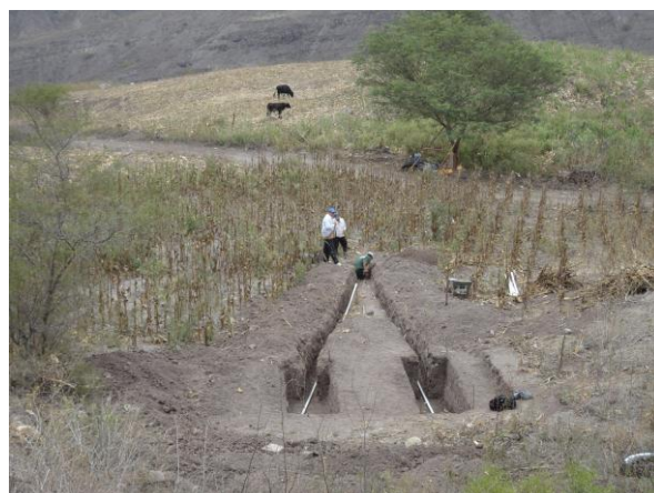
Fotografía 21. Fosas y sus respectivos canales de salida del sistema.
