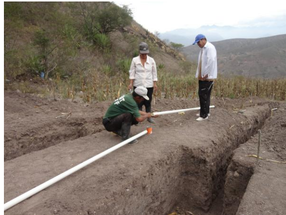
Fotografía 19. Unión de tuberías
