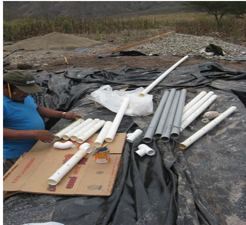
Fotografía 28. Pegado de tuberías para el sistema de drenaje.
