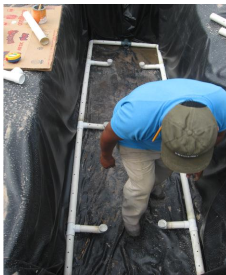
Fotografía 30. Colocación del sistema de recolección.
