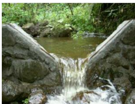
Figura 7. Vertedero triangular instalado en Lise. Fuente (PROTOS-PROMAS, 2008)
