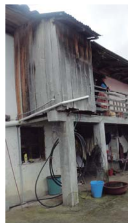
Columna reemplazada
