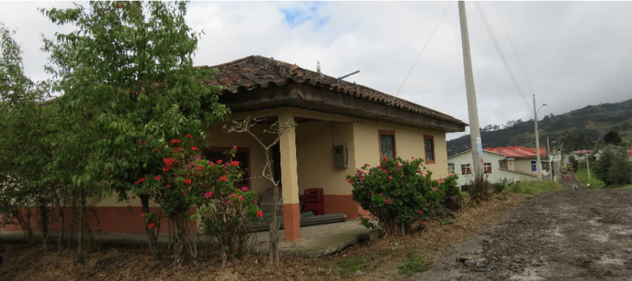
FOTOGRAFÍA 14.18 Tipo de Fachada Retranqueada
