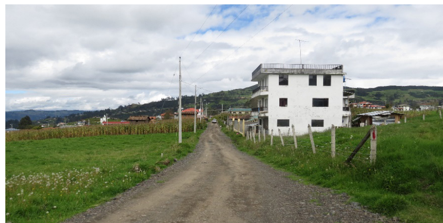
FOTOGRAFÍA N° 12.6 Calle Sucre – vista de Norte a Sur.
