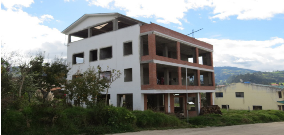
FOTOGRAFÍA N° 7.17 Edificación en construcción.
