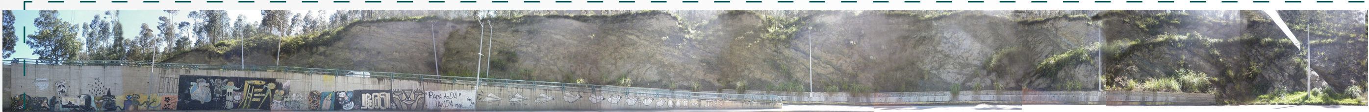
TRAMO CUATRO - d2
