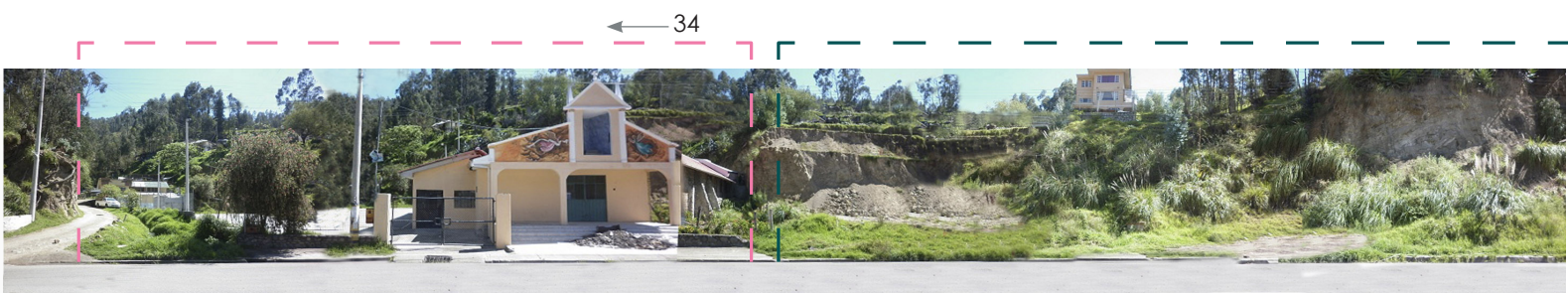
TRAMO TRES - d4
