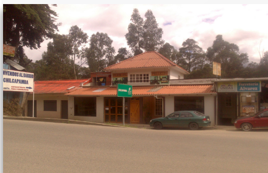
Foto IV.5. o Tramo 03_uso urbano
