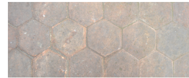
Piso de ladrillo hexagonal
