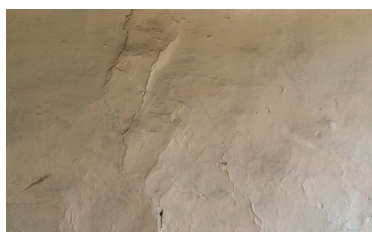
Fisura en forma de red
