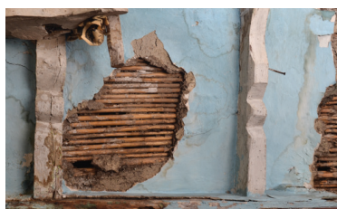
Expansión en forma de ampollas
