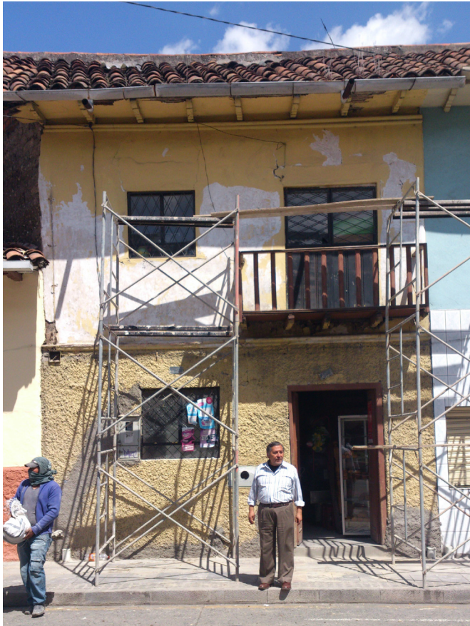
FIG 4.56: Fachada de la casa 012 en la campaña de mantenimiento
