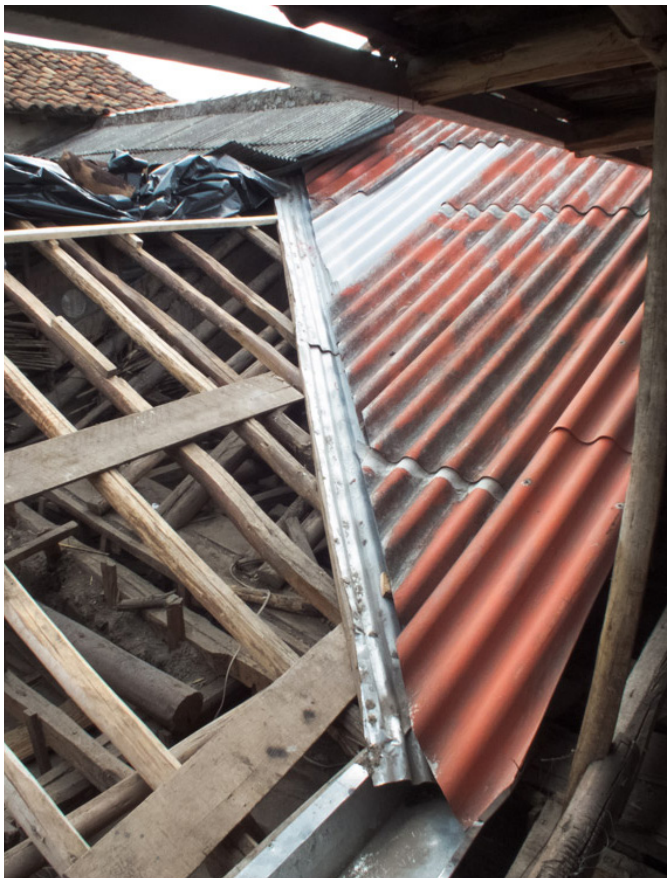
FIG 4.54: Cubierta en la ejecución de la campaña de mantenimiento
