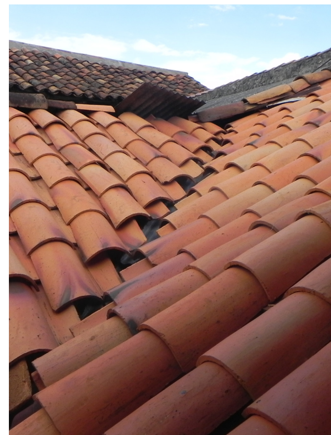
FIG 4.55: Cubierta después de la ejecución de la campaña de mantenimiento
