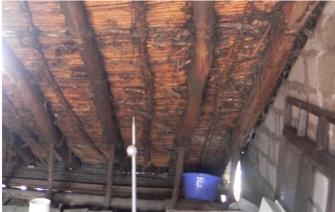
FIG 4.7: Estructura de cubierta en vivienda de la manzana de San Roque
