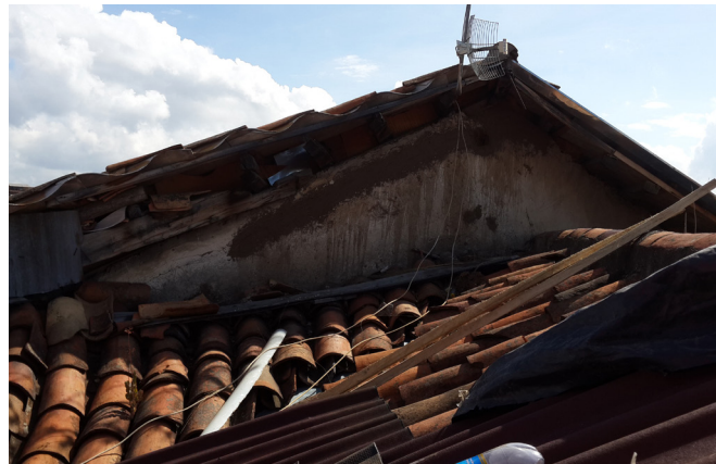
FIG 4.1: Culata de vivienda de la manzana de San Roque
