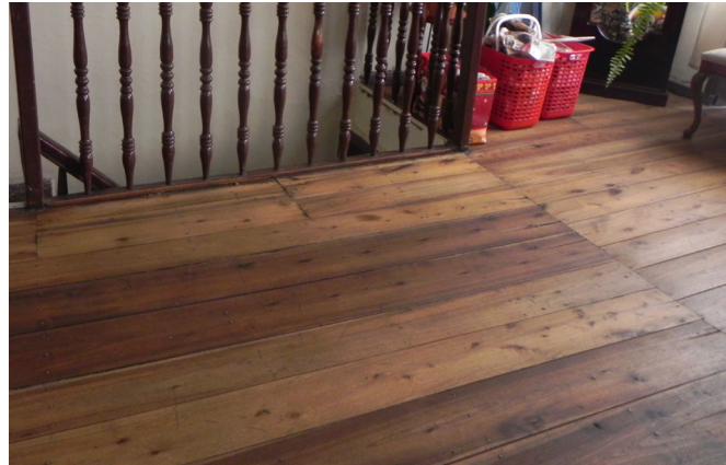
FIG 4.6: Piso de madera en vivienda de la manzana de San Roque
