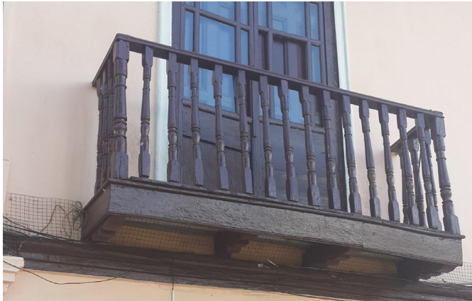
FIG 4.5: Balcón en vivienda de la manzana de San Roque
