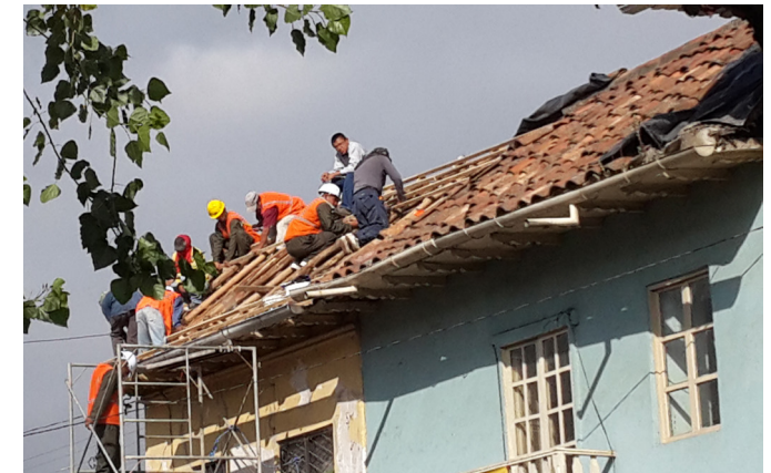
FIG 4.2: Cubierta de vivienda de la manzana de San Roque
