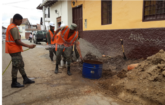
FIG 4.3: Campaña de mantenimiento en la manzana de San Roque
