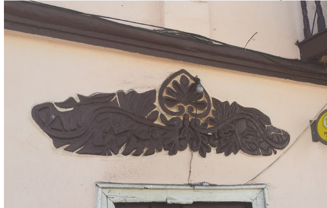
FIG 4.8: Molduras en vivienda de la manzana de San Roque
