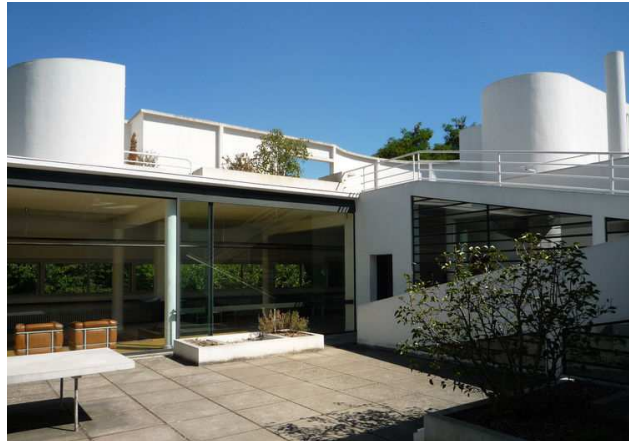
65 Vista de la rampa desde el patio exterior
