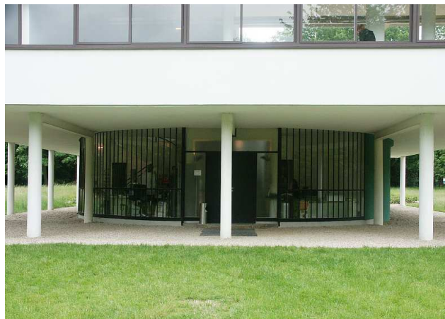
60 Camino curvo para la circulación vehicular
