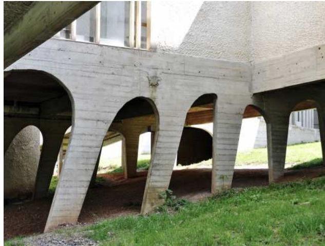
153 Pilotis y pendiente del terreno
