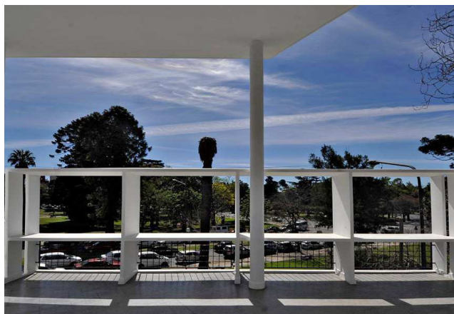
112 Brise soleil visto desde la terraza
