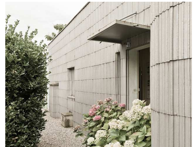
08 Recubrimiento de aluminio en la fachada
