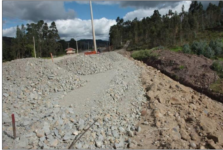
Figura 2-25: Relleno de la Alcantarilla, aguas arriba
