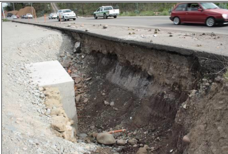
Figura 2-30: Estructura del pavimento viejo
