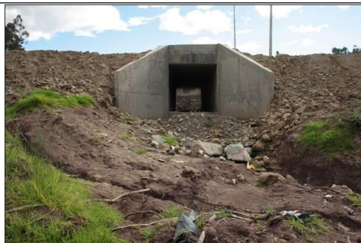
Figura 2-29: Salida de la alcantarilla
