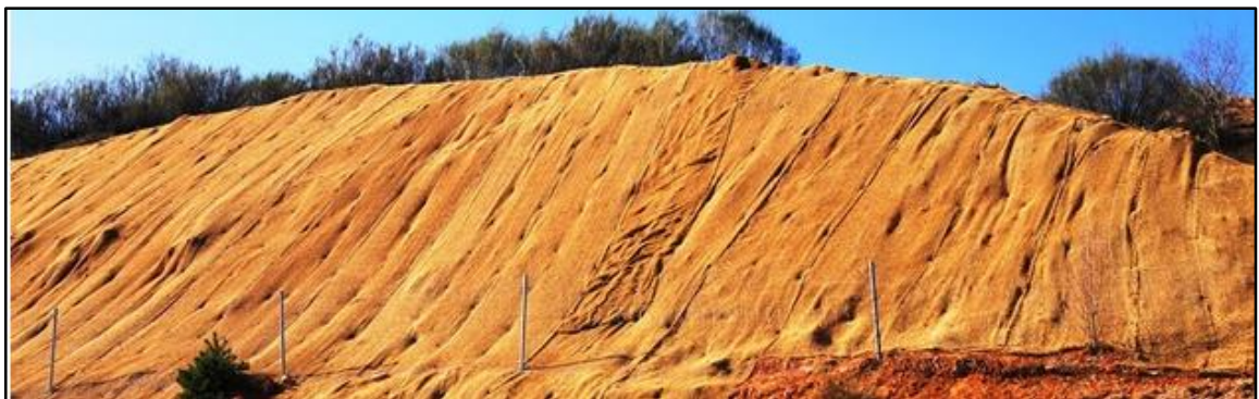
Figura 6-3: Biomanta en talud de autopista Cuenca-Azogues.
