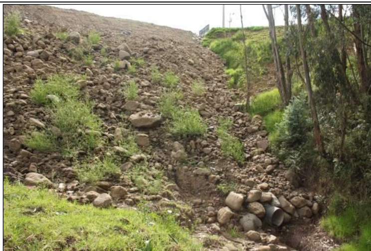
Figura 2-28: Talud del pedraplen
