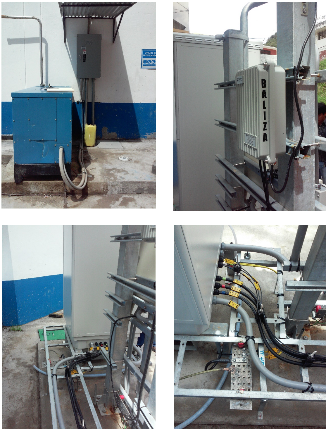
Figura 6.3 Generador de energía, control de baliza y cableado externo.
