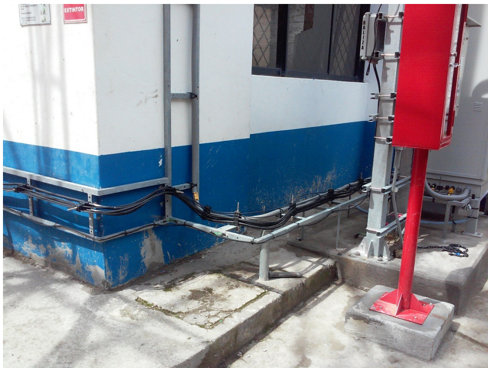
Figura 6.5 Escalerillas para sujeción del cableado.
