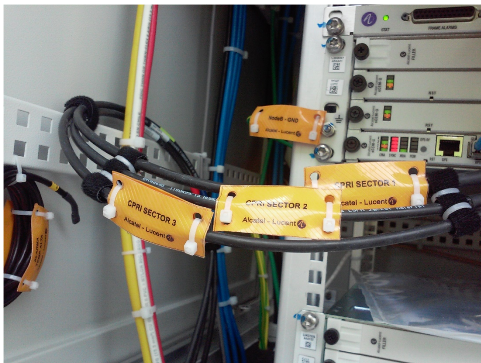
Figura 6.6 Etiquetado de los cables.
