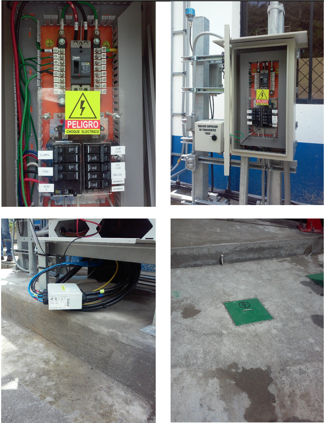
Figura 6.2 Caja de breakers para el nodoB, caja distribuidora de fibra y tapa de la puesta a tierra.
