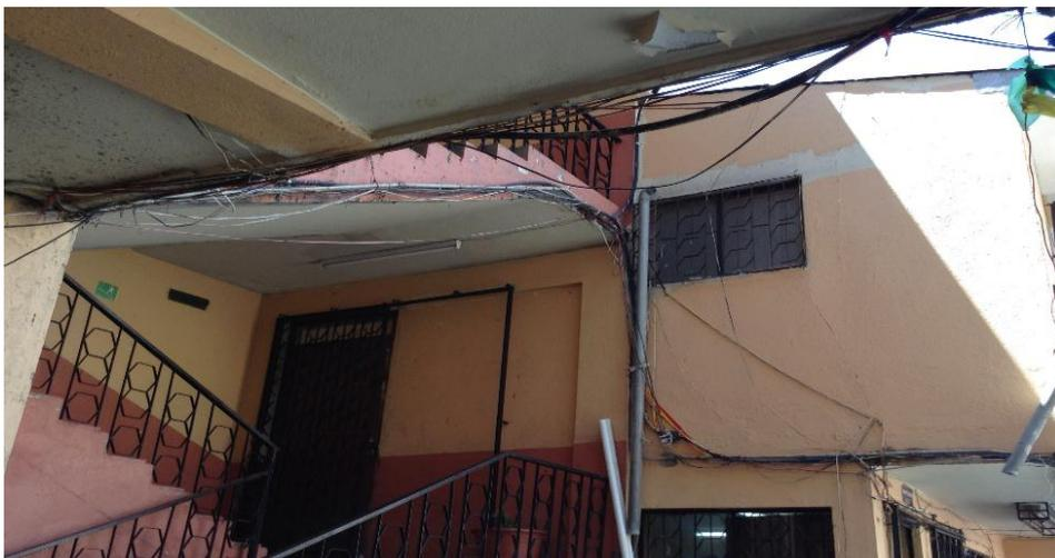
**Foto:** deterioro de infraestructura y mal estado de instalaciones eléctricas.
