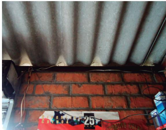
Imagen 2.75 - Infiltraciones a través de la cubierta - vivienda 4
