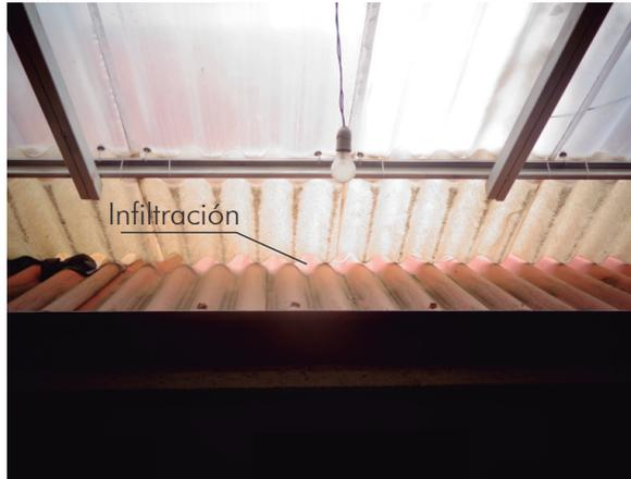
Imagen 2.62 - Infiltraciones a través de la cubierta vivienda 5
