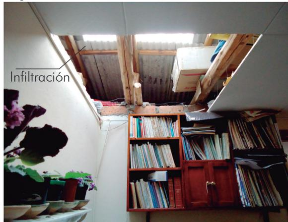
Imagen 2.63 - Infiltraciones a través del cielo raso vivienda 2
