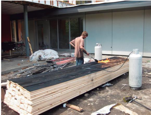
Imagen 4.2 - Ejemplo del terminado final de un panel de madera quemada
