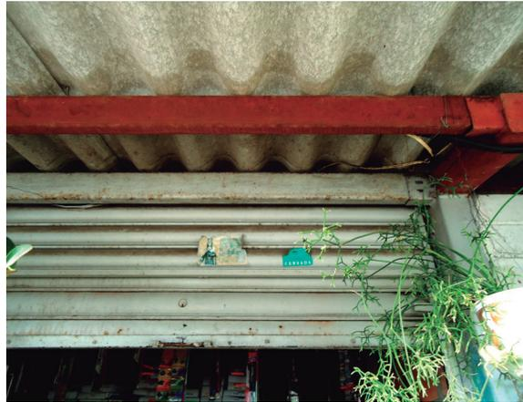
Imagen 2.74 - Infiltraciones a través de la cubierta - vivienda 2
