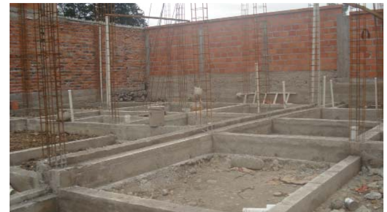
51. Cadenas de hormigón armado y arranque de columnas. Fotografía: el Autor
