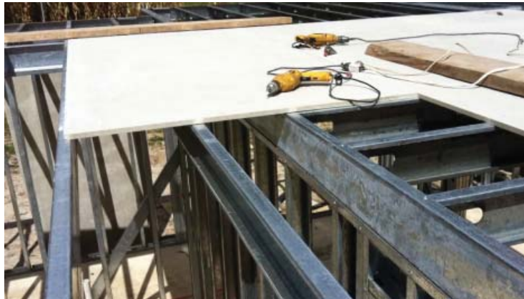
39. Rigidización de losa mediante placas de fibrocemento. Fuente: Arq. Javier Flores
