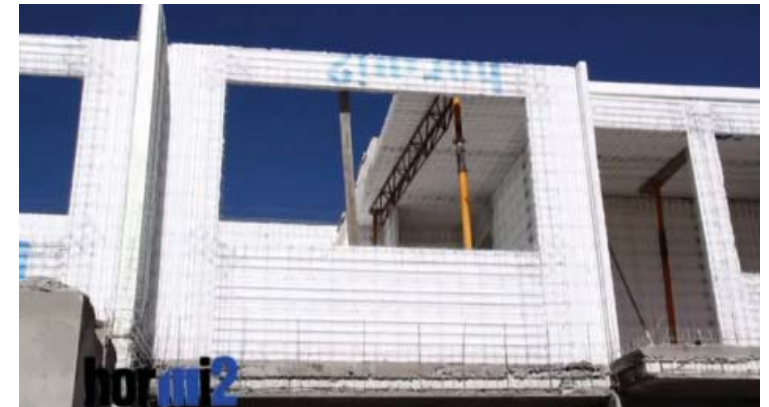
17. Corte en paneles para vanos de puertas y ventanas.
