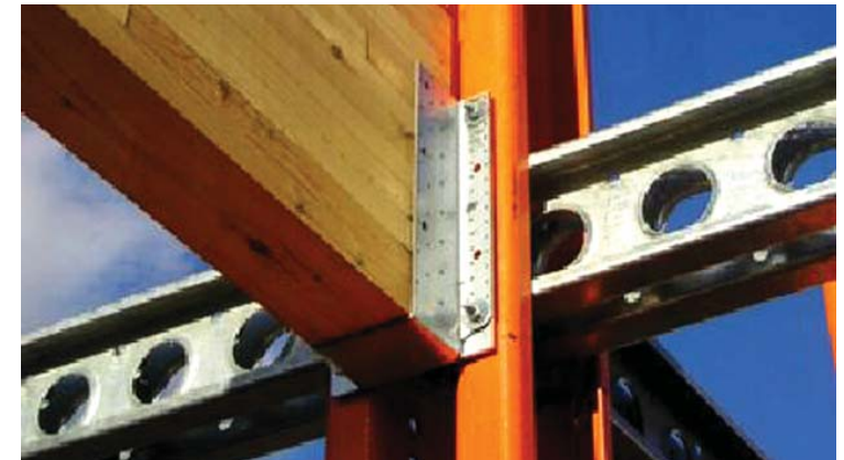
72. Unión de vigas laminadas con columnas metálicas.
