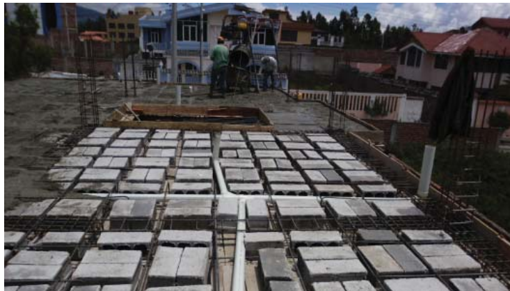
53. Fundición de losa de hormigón armado alivianada con bloque de pómez.
