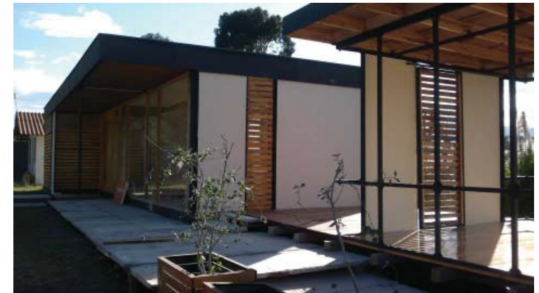
76. Perspectiva de la vivienda inicial. Fotografía: Arq. Iván Pérez
