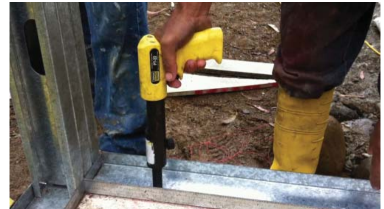
38. Anclaje de perfiles a las losa mediante pistola y fulminantes. Fuente: Arq. Javier Flores
