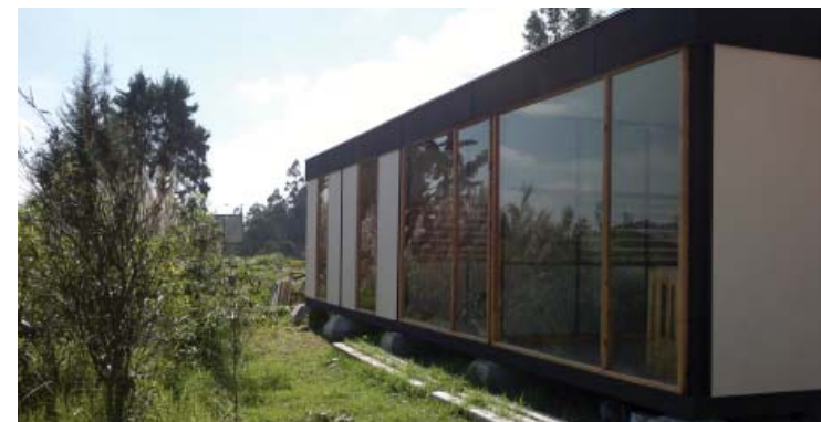
78. Acabado de paneles y carpintería. Fotografía: Arq. Iván Pérez
