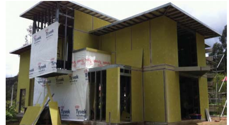
41. Colocación de membrana impermeabilizante en paredes. Fuente: Arq. Javier Flores
