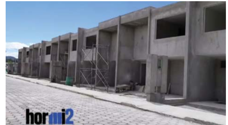
22. Terminado de la vivienda en obra gris.
