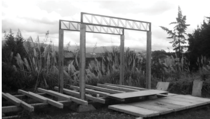
79. Proceso constructivo de incorporación de módulo adicional. Fotografía: Arq. Iván Pérez
