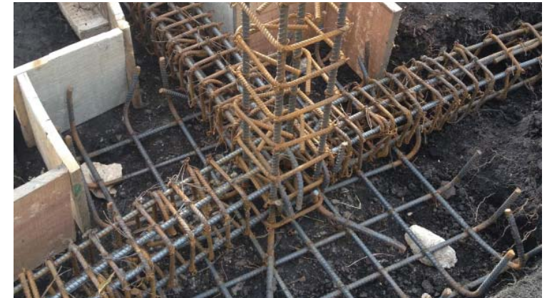
50. Armado de acero para parrilla de zapata aislada
