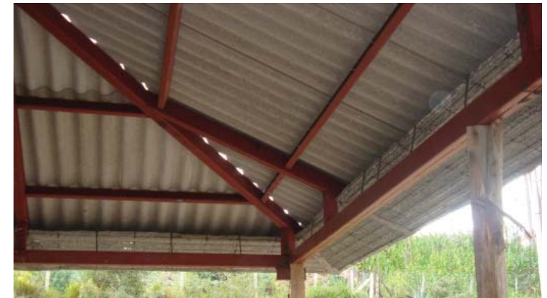
55. Colocación de fibrocemento sobre estructura metálica. Fotografía: el Autor
