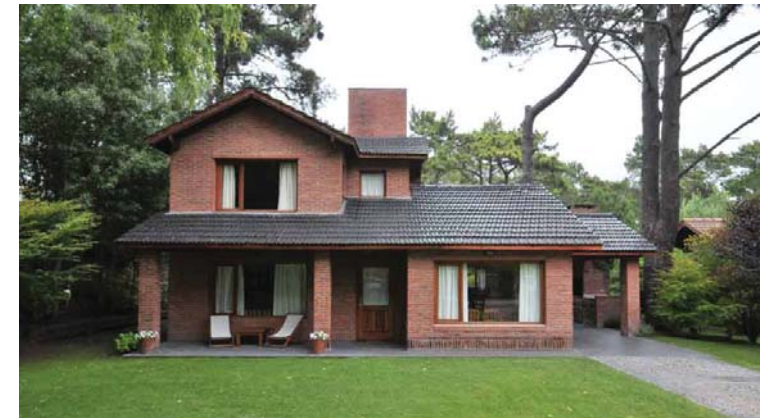
44. Vivienda finalizada de Hormigón Armado y mampostería de ladrillo.
