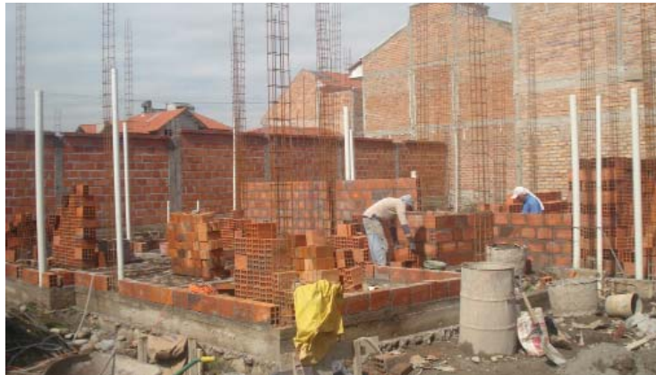
52. Colocación de mampostería de ladrillo. Fotografía: el Autor
