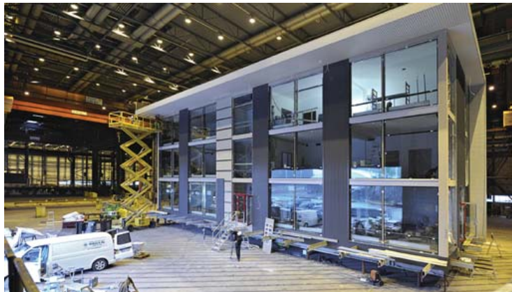
13. Industrialización por componentes. Viviendas construidas por Neapo Oy - Finlandia.
