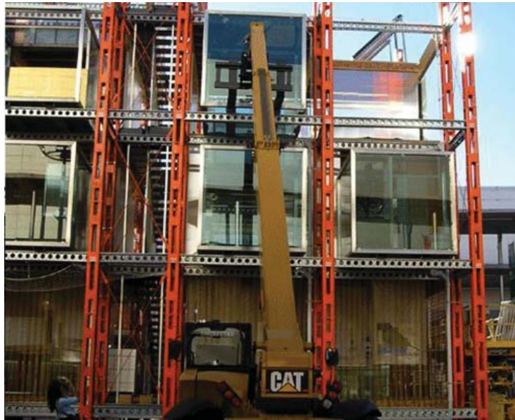
73. Montaje de cabinas mediante Caterpillar.
