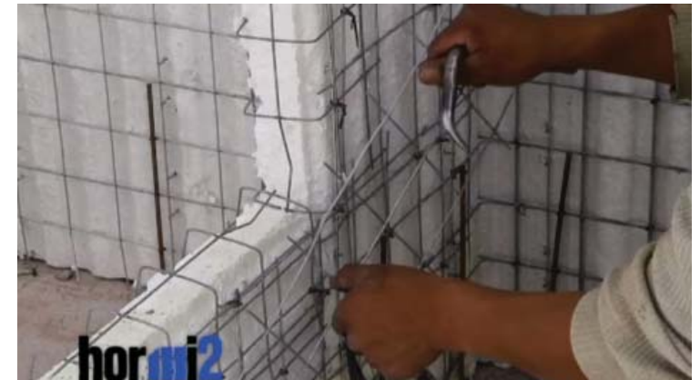
18. Refuerzo de esquinas de vanos con malla plana colocada a 45°.
