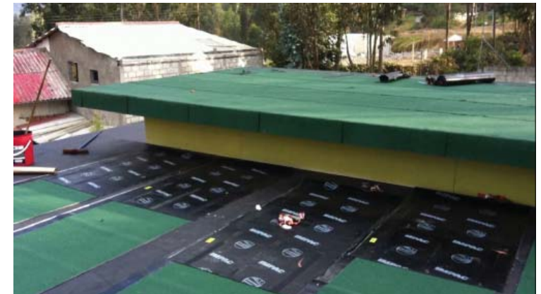
42. Colocación de membrana impermeabilizante en cubierta. Fuente: Arq. Javier Flores
