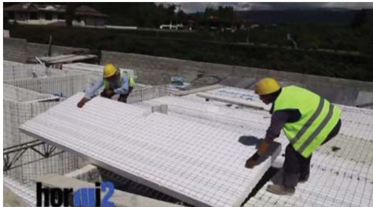
19. Colocación de paneles de losa sobre mallas angulares.
