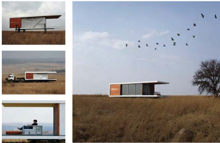
10. Zenkaya. Vivienda completamente construida en fábrica, diseñada por el Arq. Eric Bigot
