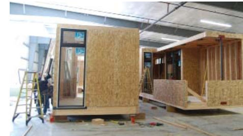
27. Vivienda modular prefabricada de Steel Framing con recubrimiento de OSB.
