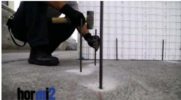
16. Colocación de chicotes en losa de cimentación.
