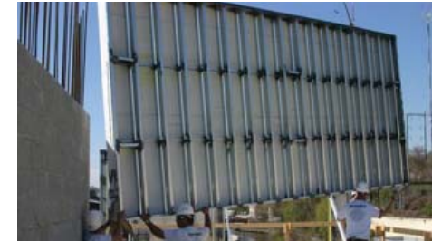
26. Construcción con Steel Framing a partir de paneles prefabricados.
