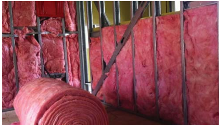
40. Colocación de aislamiento termo-acústico. Fuente: Arq. Javier Flores
