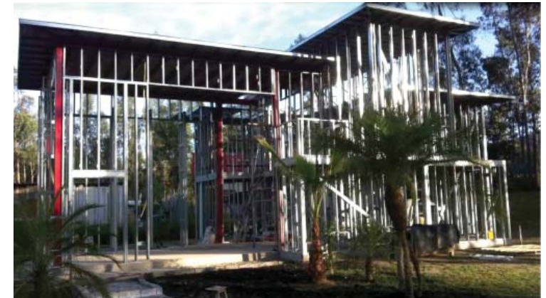
23. Proceso constructivo Steel Framing de la Casa Pavo Rumi. Fotografía: Arq. Javier Flores
