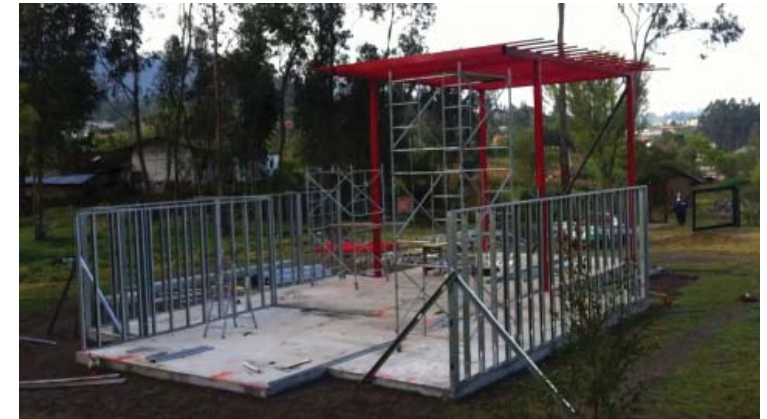
37. Montaje de paneles sobre losa. Fuente: Arq. Javier Flores
