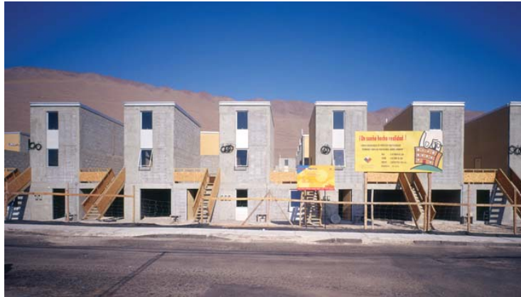
36. Quinta Monroy. Obra inicial Elemental arquitectos. Iquique, Chile. 2003-2005.
