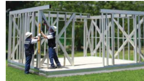
25. Construcción en obra de un módulo en Steel Framing.
