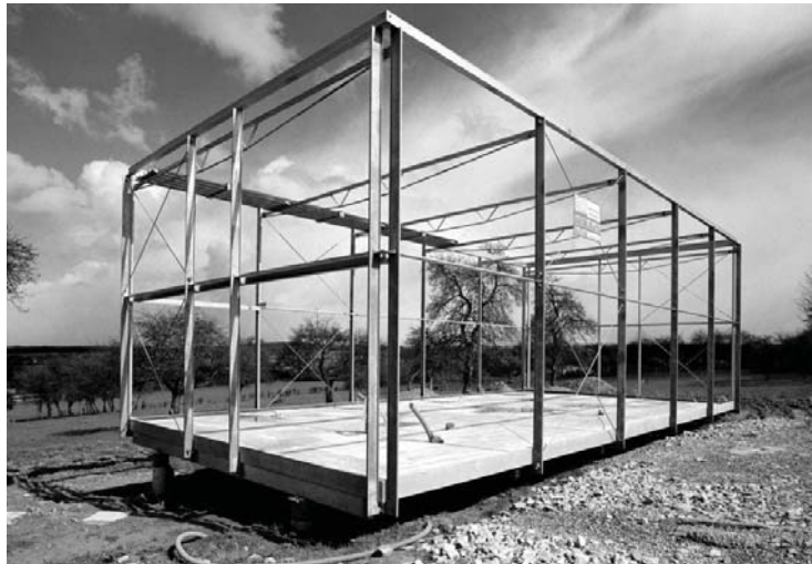
4. Proceso constructivo de la vivienda de Dethier & Associés.
