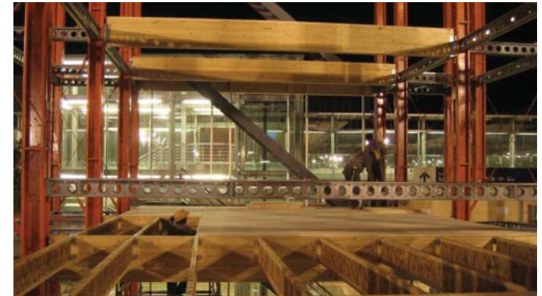
71. Montaje de vigas laminadas, viguetas TJI y tableros contrachapados.
