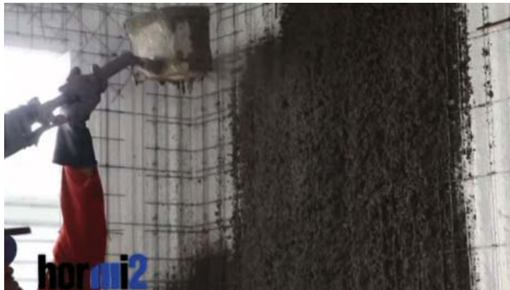
20. Lanzando de la primera capa de mortero sobre paneles en planta baja.
