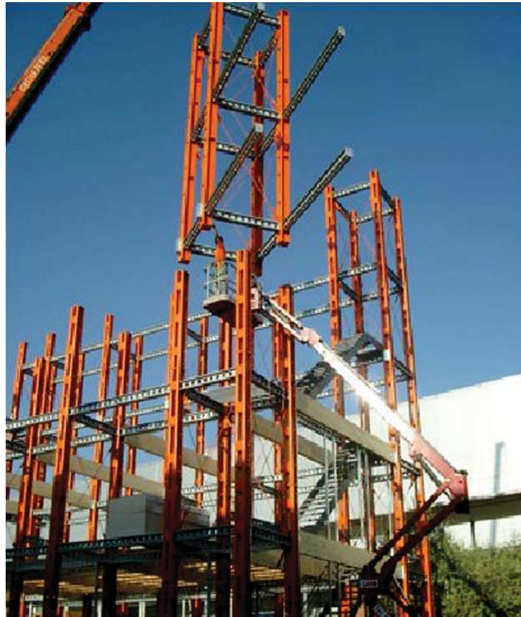
70. Montaje de estructura metálica RMD Kwikform.
