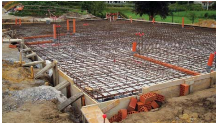
15. Armado de losa de cimentación, impermeabilización y aso de instalaciones.
