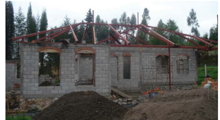
54. Armado de estructura de cubierta metálica. Fotografía: el Autor
