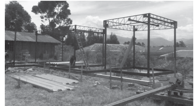
75. Proceso constructivo de vivienda inicial. Fotografía: Arq. Iván Pérez
