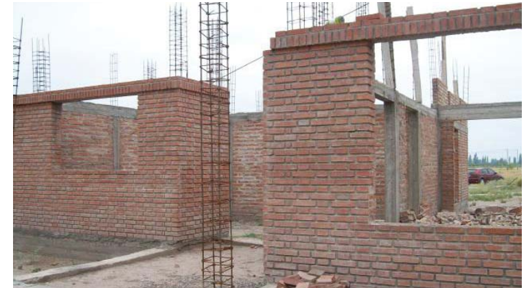
43. Proceso constructivo de una vivienda de Hormigón Armado y mampostería de ladrillo.
