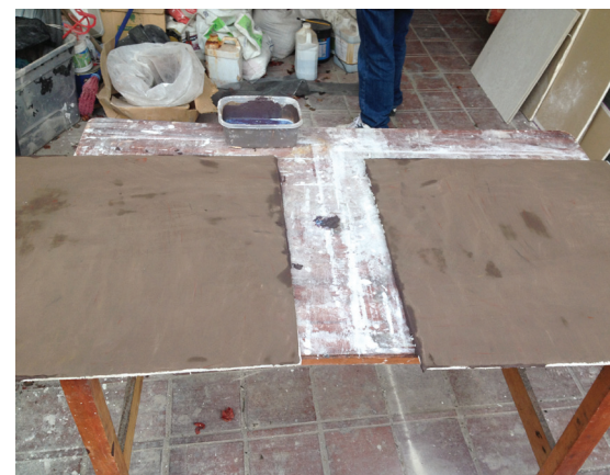
302.. Lijado de primera capa de microcemento. 303. Placas de fibrocemento con primera capa de microcemento.
