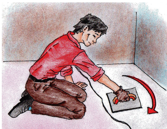
6. Colocación de microcemento, preferible dos capas de 1mm de espesor cada una, la segunda se aplica después de haber secado la primera. La colocación es en forma semicircular para evitar marcas de herramienta.
