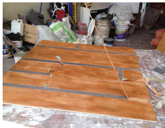
340. Ecocolor colocado sobre microcemento con waípe. 341. Retiro de cinta masquin para observar relieve de junta y duela.
