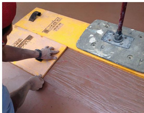
248. Colocación de antimoldante para moldes de estampado, Restaurante La Tórtola, Cuenca-Ecuador (Capturado 2014, 15 de abril) 249. Estampado de piso, Cuenca-Ecuador (Capturado 2014, 15 de abril)
