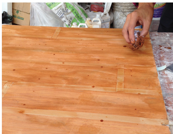
338. Colocación de capa de ecocolor con waípe. 339. Ecocolor colocado sobre microcemento.
