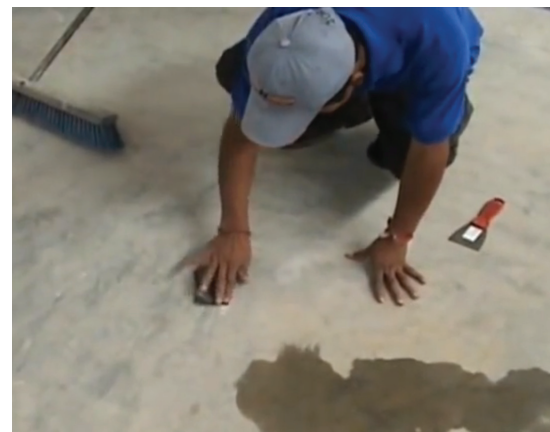
123. Preparación y limpieza de la superficie, Hotel Ritz Dan Carlton, España, Obras grupo Glasstonefloor, Aplicaciones, Proyectos Industriales, (Última actualización 2014, 10 de julio) © 2011 GlasstoneFloor
