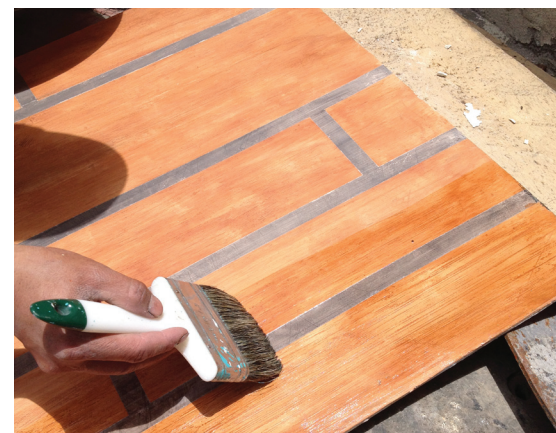
342. Pintado de juntas de duela. 343. Colocación de capas de sellante para dar por acabado la placa.
