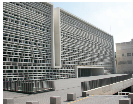
20. Hormigón Arquitectónico, Revestimiento de fachadas de hormigón con motivos, ArchiExpo, España.
