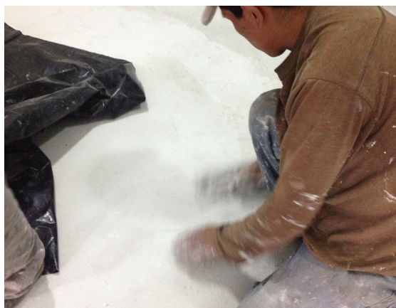
261. Mezcla de microcemento con aditivos, Restaurante La Tórtola, Cuenca-Ecuador (Capturado 2014, 17 de abril) 262. Colocación de microcemento, Restaurante La Tórtola, Cuenca-Ecuador (Capturado 2014, 16 de abril)
