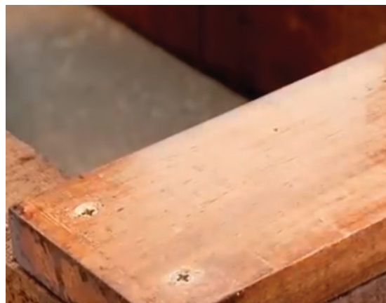
186. Atornillado de las duelas de madera a las tiras de madera, Cuenca-Ecuador (Capturado 2014, 02 de septiembre) 187. Corte de duelas, Cuenca-Ecuador (Capturado 2014, 03 de septiembre)
