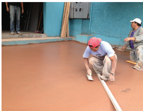
246. Colocación de endurecedor con pigmentos, Restaurante La Tórtola, Cuenca-Ecuador (Capturado 2014, 15 de abril) 247. Nivelación final de losa, Cuenca-Ecuador (Capturado 2014, 15 de abril)
