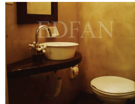
156. Colocación de la capa de microcapa, Vivienda familiar (Bogotá), Colombia, Obras grupo Edfan, (Última actualización 2014, 24 de julio) 157. Acabado final de revestimiento de microcemento con ácidos de color terracota, Vivienda familiar (Bogotá), Colombia, Obras grupo Edfan, (Última actualización 2014, 24 de julio)
