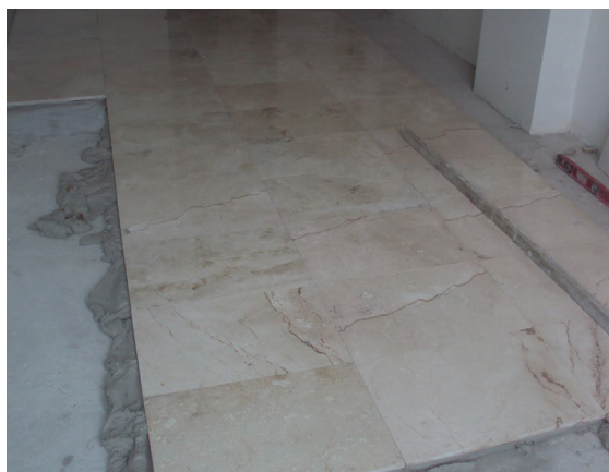
277. Colocación de piezas de mármol (Capturado 2014, 20 de junio) 278. Colocación de piezas de mármol (Capturado 2014, 20 de junio)
