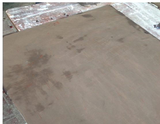
300. Colocación de mezcla de microcapa. 301. Primera capa de microcemento colocada terminando su proceso de secado.
