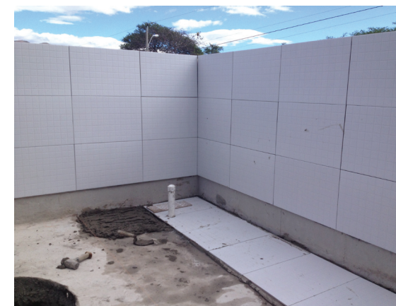
204. Colocación de piezas de porcelanato, Yunguilla-Ecuador (Capturado 2014, 08 de septiembre) 205. Colocación de empore sobre porcelanato, Yunguilla-Ecuador (Capturado 2014, 09 de septiembre)
