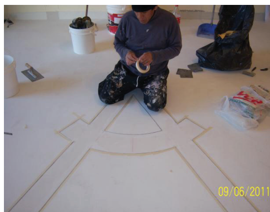
146. Aplicación de microcemento sobre la capa de microcapa, Cafetería Mocca (Sao Paulo), Brasil, Obras grupo Fullcover Brasil, (Última actualización 2014, 23 de julio) 147. Trazado de diseños y aplicación de ácidos. Cafetería Mocca (Sao Paulo), Brasil, Obras grupo Fullcover Brasil, (Última actualización 2014, 23 de julio)
