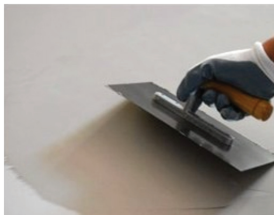
166. Colocación de microcapa sobre revestimiento cerámico, Aplicaciones, Grupo Edfan, España (Última actualización 2014, 24 de julio) 167. Aplicación de microcemento sobre microcapa, Aplicaciones, Grupo Edfan, España (Última actualización 2014, 24 de julio)
