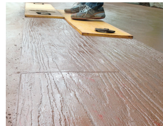
250. Estampado de piso, Cuenca-Ecuador (Capturado 2014, 15 de abril) 251. Estampado de piso, Cuenca-Ecuador (Capturado 2014, 15 de abril)
