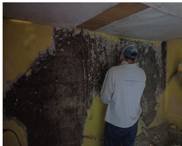
Desarmado del Cielo Raso
