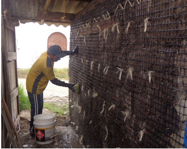
Remojo de Muro Fuente: Grupo de Tesis
