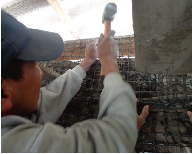
Sujección de la Geomalla a Viga con Grapas Metélicas
