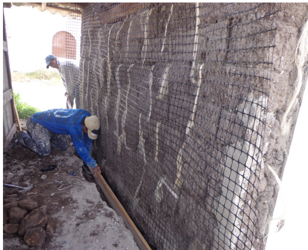
Colocación de Prensas de Madera Fuente: Grupo de Tesis
