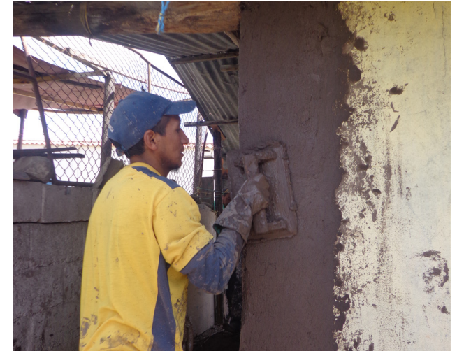
Proceso Revoque Fuente: Grupo de Tesis
