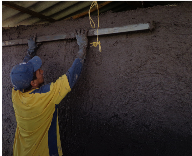
Proceso Revoque Fuente: Grupo de Tesis
