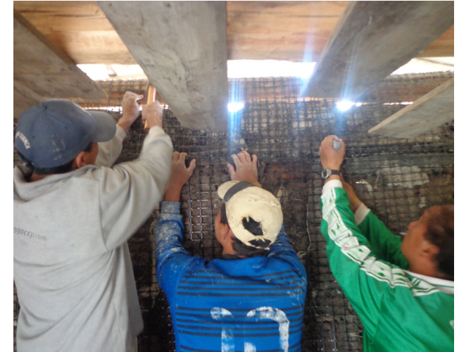
Sujección de Geomalla Fuente: Grupo de Tesis
