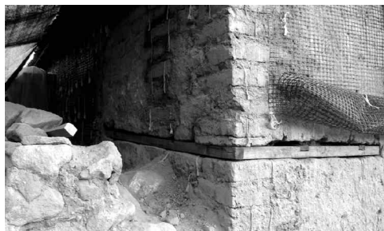
Llave de amarre en encuentro de muros. FUENTE: FUNDACION ALTIPLANO, “Guía práctica para talleres de capacitación en la restauración en adobe”, Chile, Arica, Sexta Edición, 2010 – 2012. Pág. 25
