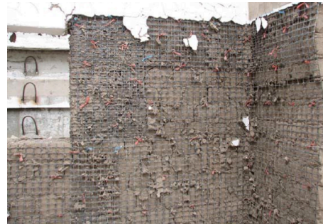
Muro de adobe con refuerzo y revoque Fuente: DISEÑO SISMICO DE MUROS DE ADOBE REFORZADOS CON GEOMALLA, DANIEL TORREALVA, SEPTIEMBRE 2009
