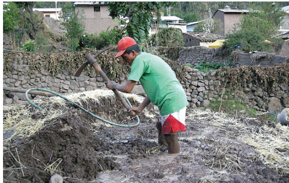
MEZCLA DE ADOBE. http://commons.wikimedia.org/wiki/File: Mezcla_de_adobe.jpg
