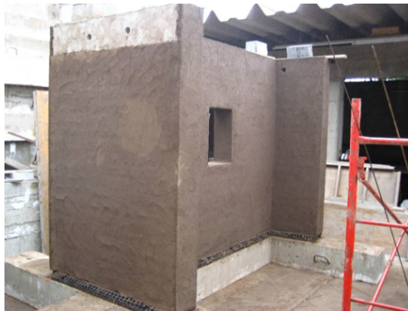
Muro de adobe con refuerzo y revoque Fuente: DISEÑO SISMICO DE MUROS DE ADOBE REFORZADOS CON GEOMALLA, DANIEL TORREALVA, SEPTIEMBRE 2009
