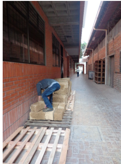
Almacenaje de adobes sobre pallets de madera Foto: Grupo de Tesis
