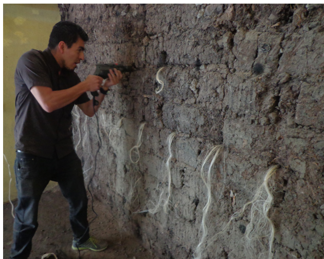
Perforación del Muro de Adobe Fuente: Grupo de Tesis
