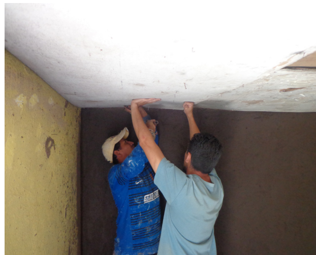
Colocación de Plywood Fuente: Grupo de Tesis
