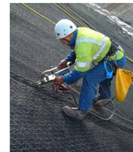
COLOCACION DE GEOMALLAS EN OBRA. http://images03.olx.com.ve/ui/10/45/54/1292724577_147934154_2-GEOSINTETICOS-BRITVEN-San-Antonio-de-los-Altos.jpg
