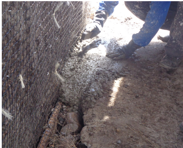
Fundición de Zanja Fuente: Grupo de Tesis
