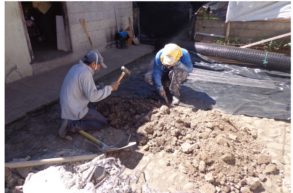
Preparación de la Tierra Para Revoque Fuente: Grupo de Tesis
