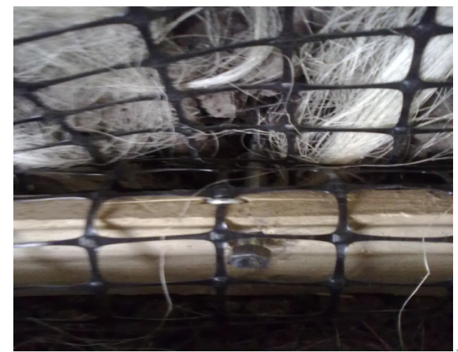
Sujección de Geomalla a Tabla de Eucalipto mediante Varilla Fuente: Grupo de Tesis
