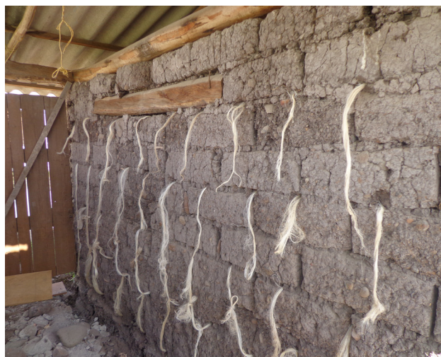
Muro Exterior con Rafias Fuente: Grupo de Tesis
