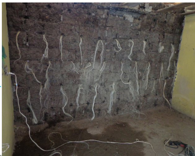
Muro Interior con Rafias Fuente: Grupo de Tesis
