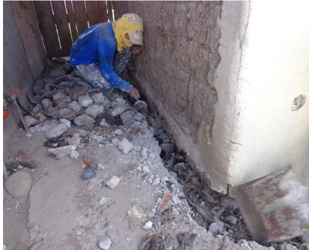
Excavación de Zanja en Muro Externo Fuente: Grupo de Tesis
