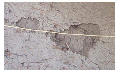
Desprendimiento de Revoque Fuente: Grupo de Tesis
