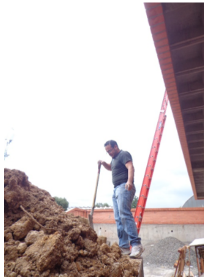
Almacenaje de tierra de mortero Foto: Grupo de Tesis
