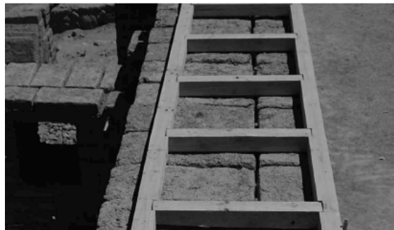
VIGA SOLERA FUNDACION ALTIPLANO, "Guía práctica para talleres de capacitación en la restauración en adobe", Chile, Arica, Sexta Edición, 2010 – 2012. Pág. 7
