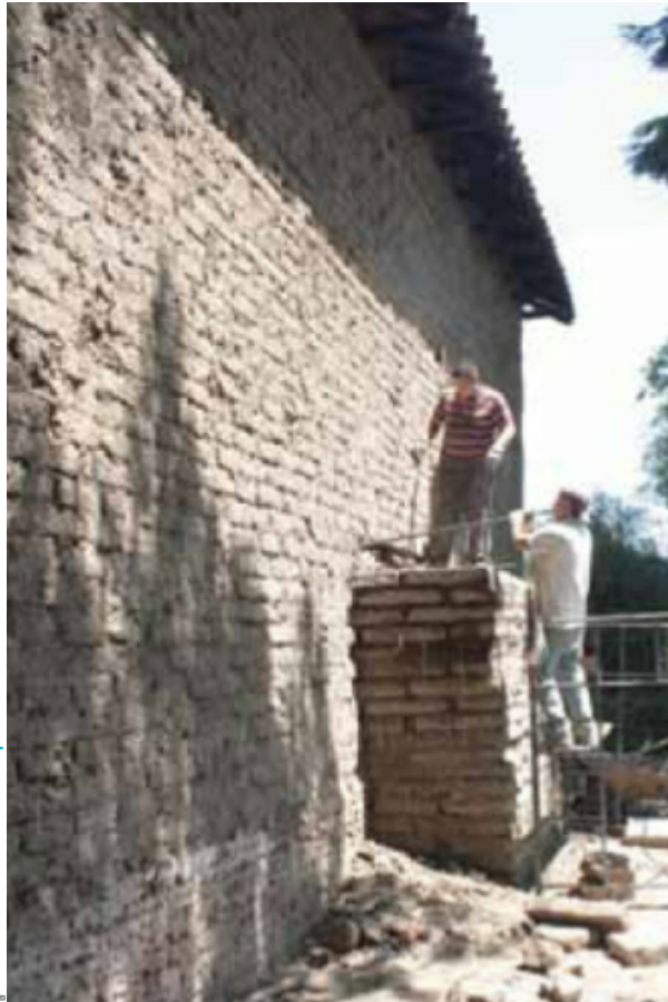
CONSTRUCCIÓN DE CONTRAFUERTE. www.123cua.cl
