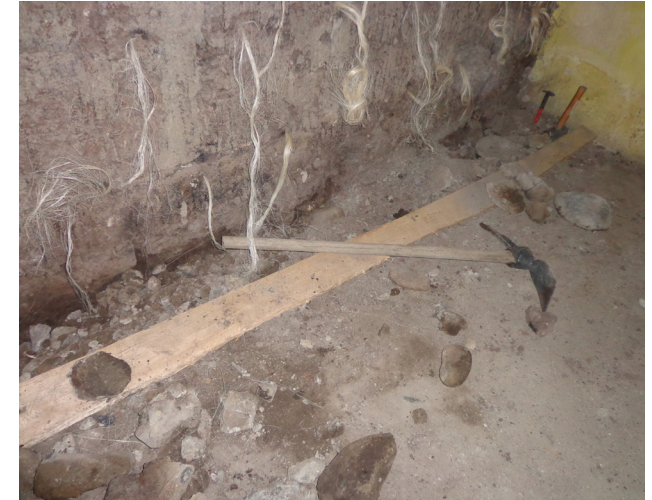
Excavación de Zanja en Muro Interno Fuente: Grupo de Tesis
