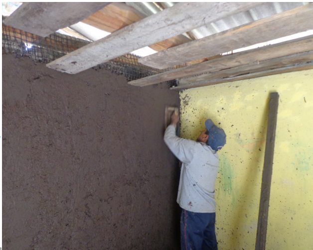
Revoque Muro Interior Fuente: Grupo de Tesis
