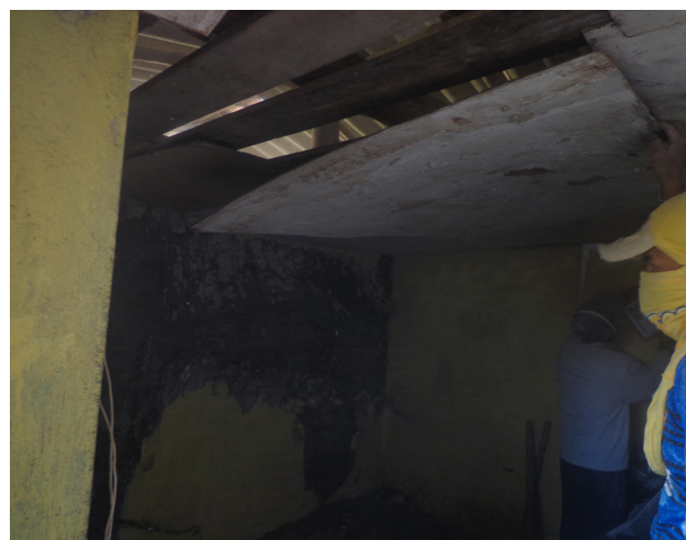
Desarmado del Cielo Raso
