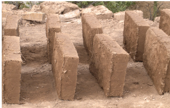
SECADO DE ADOBES AL CANTO. http://miturismoalternativo.blogspot.com/2012/01/fotografia-rural-proceso-constructivo.html
