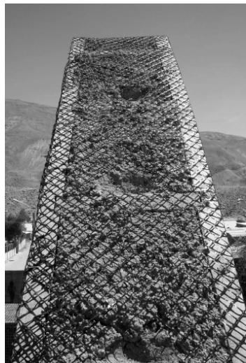
VIGA SOLERA CON GEOMALLA FUNDACION ALTIPLANO, "Guía práctica para talleres de capacitación en la restauración en adobe", Chile, Arica, Sexta Edición, 2010 – 2012. Pág. 35
