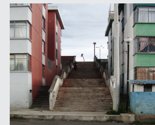
256. Fotografía: Escalinatas Multifamiliares_ Av. Loja_ Autoras de la tesis_ 2014.
