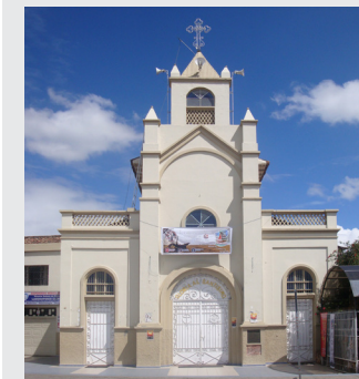
253. Fotografía: Plazoleta_ Iglesia Santa Marianita del Arenal, Vía antigua a Baños_ Autoras de la tesis_ 2014.
