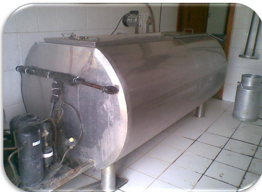
Fotografía 20. Granja de Iruis. Lechería: Tanque frío – Ciencia Agropecuarias. Fuente: Grupo de trabajo, 26 Junio 2014.
