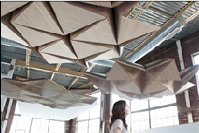
FOTO 044 DISPOSITIVOS DE RESONANCIA VARIABLE Fuente: http://www.metalocus.es/content/es/system/files/imagecache/blog_content_images/images-lead/46_website-images005.jpg Elaboración: Archivo de Tesis.
