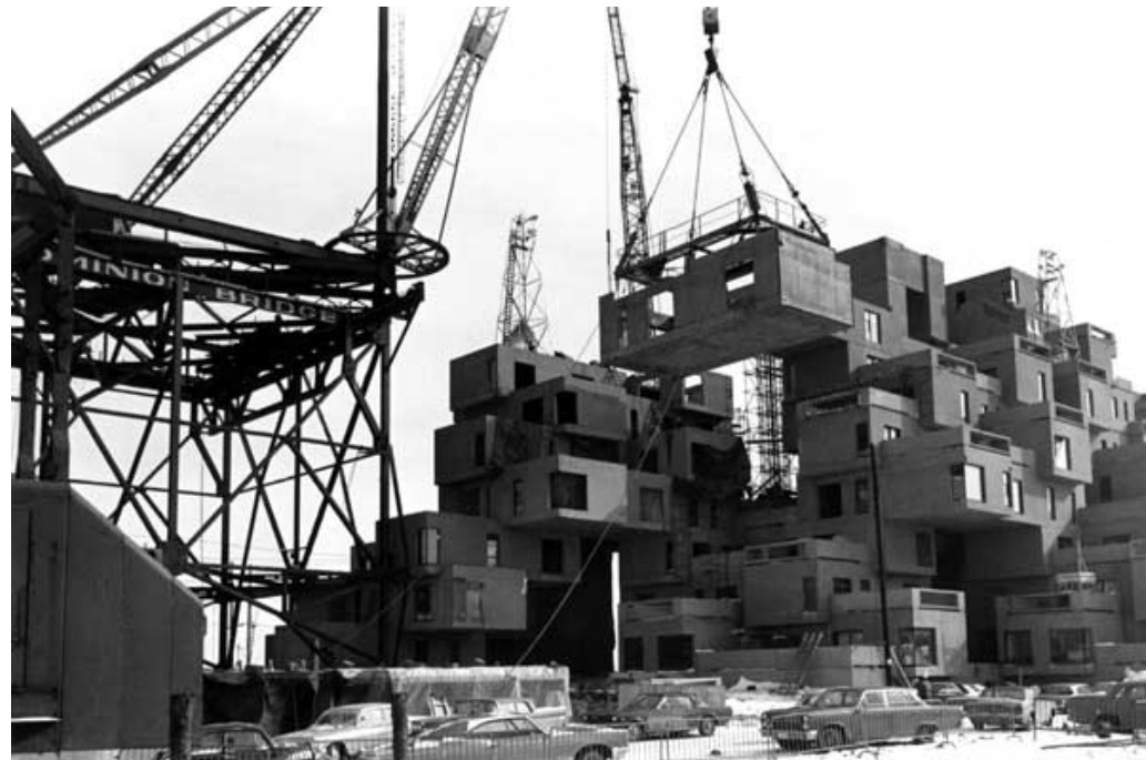
17 Montaje de Viviendas Prefabricadas Habitat '67, Montreal, Quebec, Canadá Moshe Safdie
