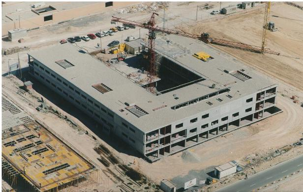
108. Foto de la construcción\_Colocación de paneles de homigón
