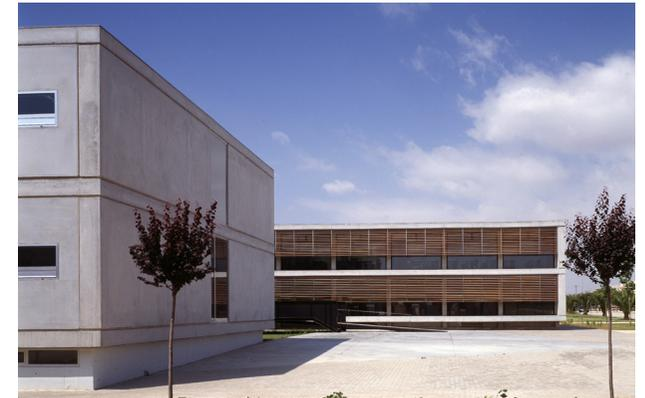
113. Paneles prefabricados
