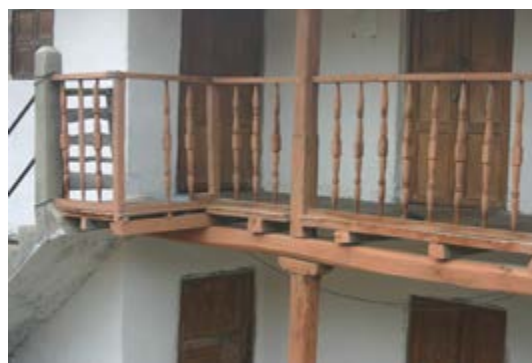
Figura 1.90. Pórtico típico de una vivienda de adobe con estructura de madera. Casa en Susudel-Azuay / Fuente: Daniel Enríquez M.
