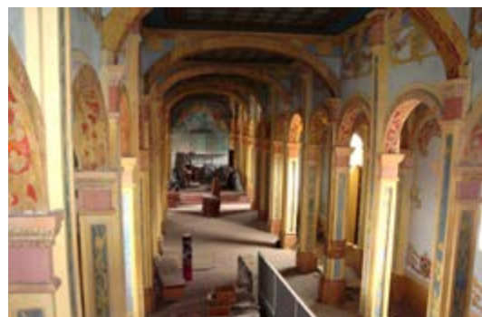
Figura 1.16. Iglesia de Todosantos. Interior, estructura de la nave central. Cuenca-Ecuador / Fuente: Daniel Enríquez M.
