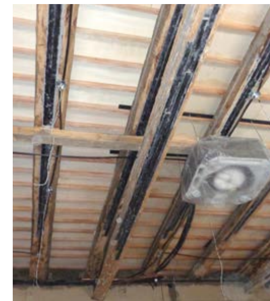
Figura 3.17. Fibras de carbono aplicadas a vigas de madera con 7m. de longitud. Fuente: Daniel Enríquez M. / Escuela central de Cuenca.
