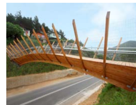
Figura 1.96.a Puente de Zapallar. Chile-Petorca / Fuente: http://www.plataformaarquitectura.cl/2009/01/19/puente-peatonal-en-zapallar-enrique-browne/
