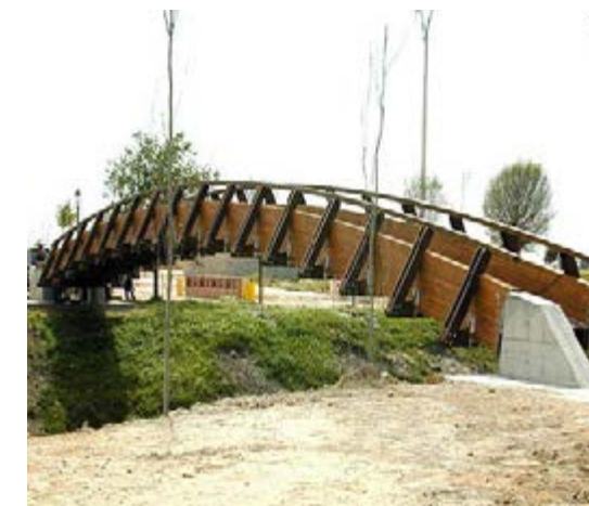
Figura 1.102. Puente en Ciudad Real, España. Luz: 33 metros. / Fuente: EDEM. "Tecnologías De La Madera Aplicadas Al Diseño De Estructuras". S.I.,s.e.,s.f.
