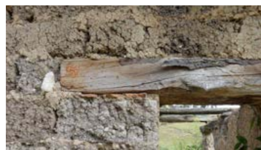
Figura 2.4. Dintel de madera de Capulí, afectada superficialmente por xilófagos y hongos. / Fuente: Daniel Enriquez M.
