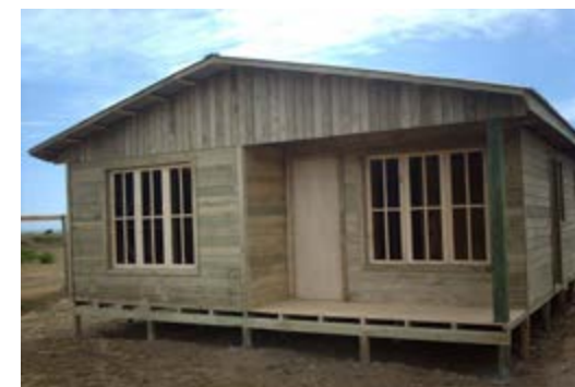
Figura 1.12. Vivienda prefabricada en madera. Comunidad de Buin-Chile / Fuente: www.casasbuin.cl
