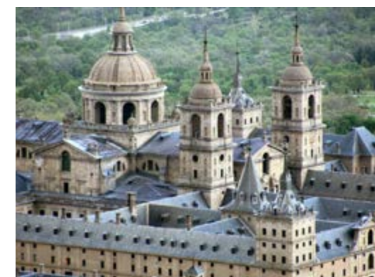
Figura 2.3. Cubiertas sustituidas en el Monasterio Escorial en Madrid. Estado actual / Fuente: http://www.monasteriodelescorial.com
