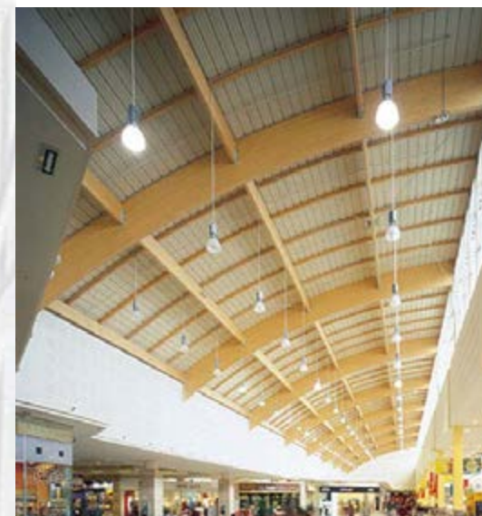
Figura 1.99. Centro comercial en Álava, España. Arcos biarticulados. Luz: 15 metros. Fuente: EDEM. "Tecnologías De La Madera Aplicadas Al Diseño De Estructuras". S.I.,s.e.,s.f.
