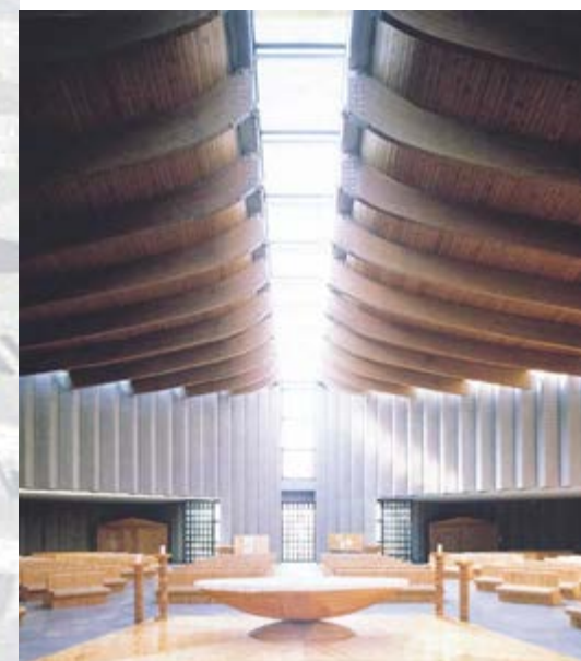
Figura 1.101. Iglesia de Santa María del Redentor, Roma, Italia. Vigas curvas biarticuladas. Luz máxima: 28 metros. / Fuente: EDEM. "Tecnologías De La Madera Aplicadas Al Diseño De Estructuras". S.I.,s.e.,s.f.
