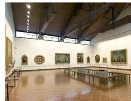
Figura 1.8. Sala Botticelli en la Galería Uffizi de Florencia. Cerchas de Madera elaboradas por G. Vasari / Fuente: www.erc.com/projects/museum/the-uffizi-3043/es/intro-1.php
