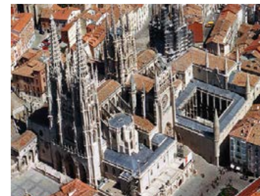
Figura 2.2. Cubiertas sustituidas en la catedral de Burgos. Estado actual / Fuente: http://www.cpas.es/burgos
