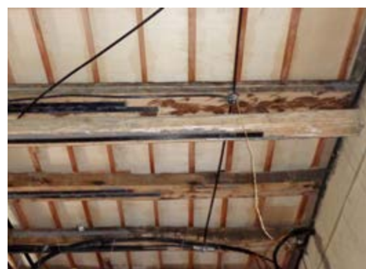
Figura 3.6. Reforzamiento estructural mediante fibras de carbono. Fuente: Daniel Enríquez M.
