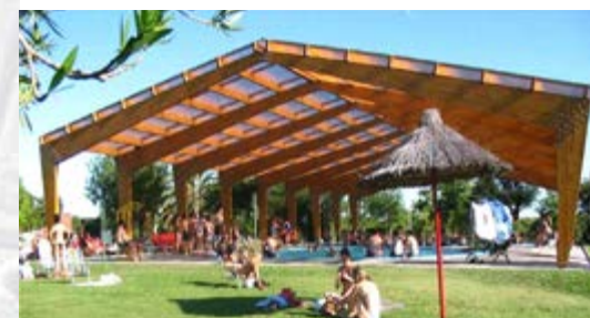
Figura 1.100. Complejo termal Daymán, Salto, Uruguay. Pórticos triarticulados. Luz libre: 18 metros. / Fuente: EDEM. "Tecnologías De La Madera Aplicadas Al Diseño De Estructuras". S.I.,s.e.,s.f.
