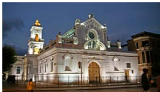
Figura 1.13. Iglesia del Sagrario, Fachada Exterior. Ubicada en Cuenca-Ecuador / Fuente: www.cuencaecuador.com .
