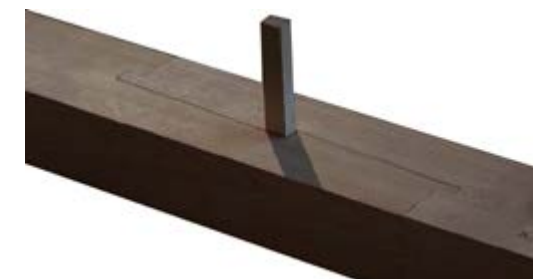
Figura 1.62. Empalme con llave de madera. / Fuente: ENSAMBLES, EMPALMES y ACOPLAMIENTOS. http://dc303.4shared.com/doc/A-_BAFAU/preview.html
