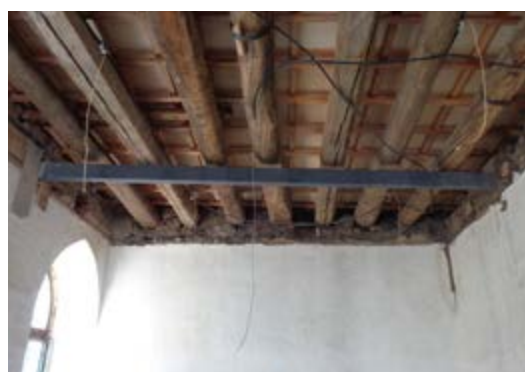
Figura 3.2. Reforzamiento estructural mediante cajas metálicas transversales a la estructura de madera. Fuente: Daniel Enriquez M.
