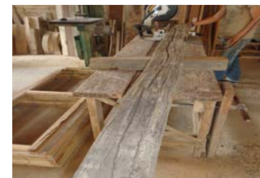
Figura 2.23. Viga A. Grupo "I", madera de 100 años./ Fuente: Daniel Enríquez M.
