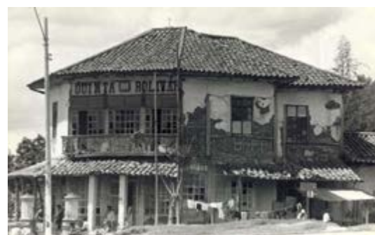
Figura 2.1. Fachada principal, Quinta Bolívar. Estado previo a la intervención realizada en el 2004. / Fuente: archivo fotográfico del Banco Central, años 80's aprox.
