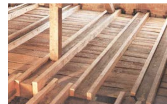
Figura 3.3. Reforzamiento estructural a partir de piezas de madera. Fuente: Daniel Enriquez M.
