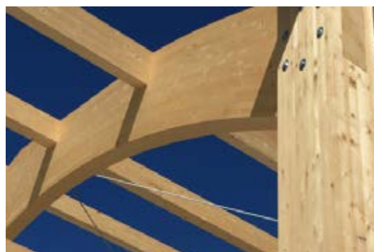
Figura 1.93. Estructura de madera laminada. / Fuente: PABST. http://www.pabst-holz.com/es/productos/madera-laminada
