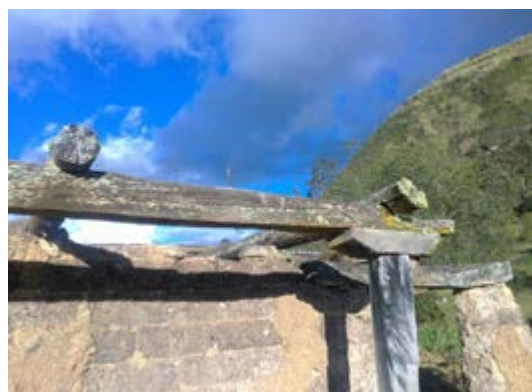
Figura 1.91. Ruinas de una vivienda vernacular con el sistema poste y viga. Cumbe-Azuay / Fuente: Daniel Enríquez M.
