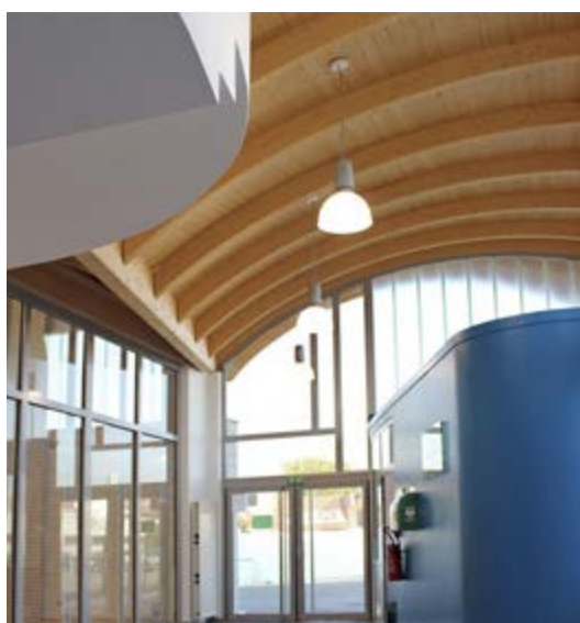
Figura 1.97.b Vigas curvas de madera laminada. Acceso al gimnasio / Fuente: http://www.plataformaarquitectura.cl/2012/12/29/gimnasio-regis-racine-atelier-darchitecture-alexandre-dreysse/
