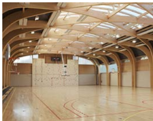
Figura 1.97.c Cancha cubierta del gimnasio Regis Racine. Porticos cruzados. / Fuente: http://www.plataformaarquitectura.cl/2012/12/29/gimnasio-regis-racine-atelier-darchitecture-alexandre-dreysse/
