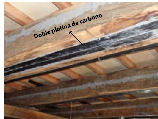
Figura 3.15. Reforzamiento mediante fibras de carbono. Fuente: Daniel Enríquez M. / Escuela central de Cuenca.
