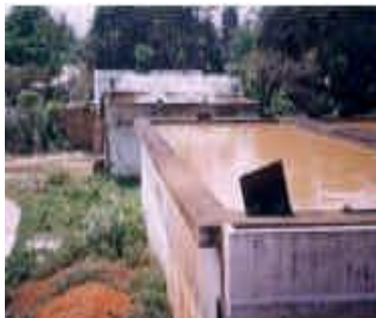
Figura N° 1. Unidad Potabilizadora de Agua en Faridpur utilizando luz solar y filtración. (Reduce la concentración de arsénico de 220 \mu\text{g/L} a 42 \mu\text{g/L} ).
