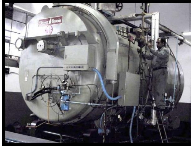
Ilustración 5.2. Caldera tipo pirotubular
