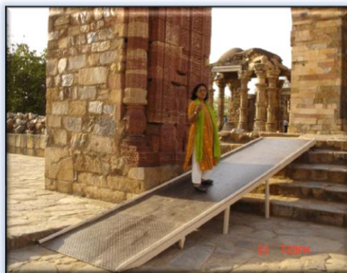
Ilustración 33: Convertible, rampas desmontable.
